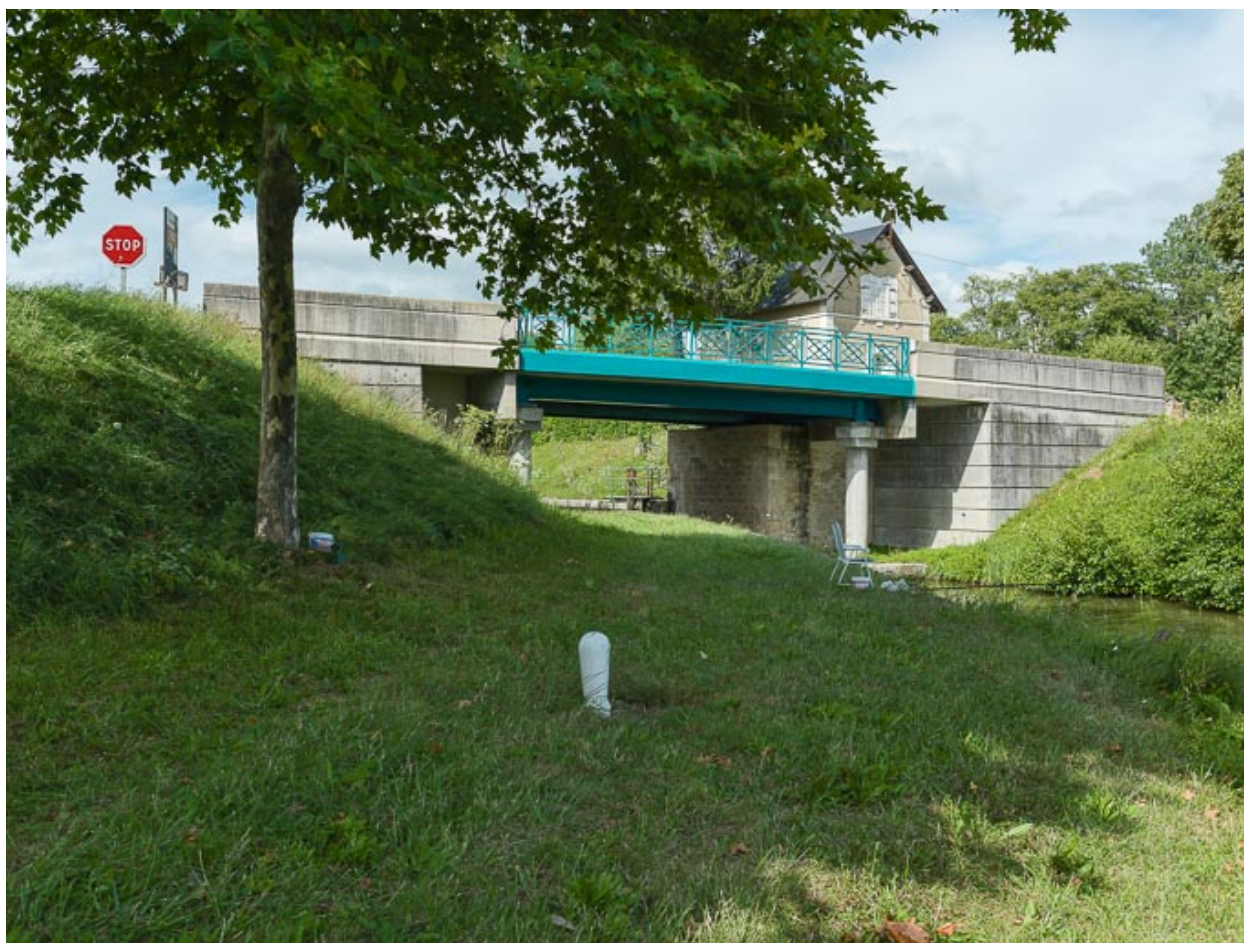
Vue d'ensemble du pont.
