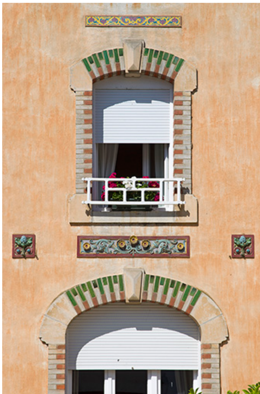
Détail de baies de l'avant-corps.
