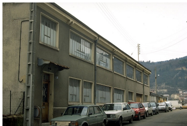
Façade antérieure. Phot. Laurent Poupard IVR43_19923901156ZA
