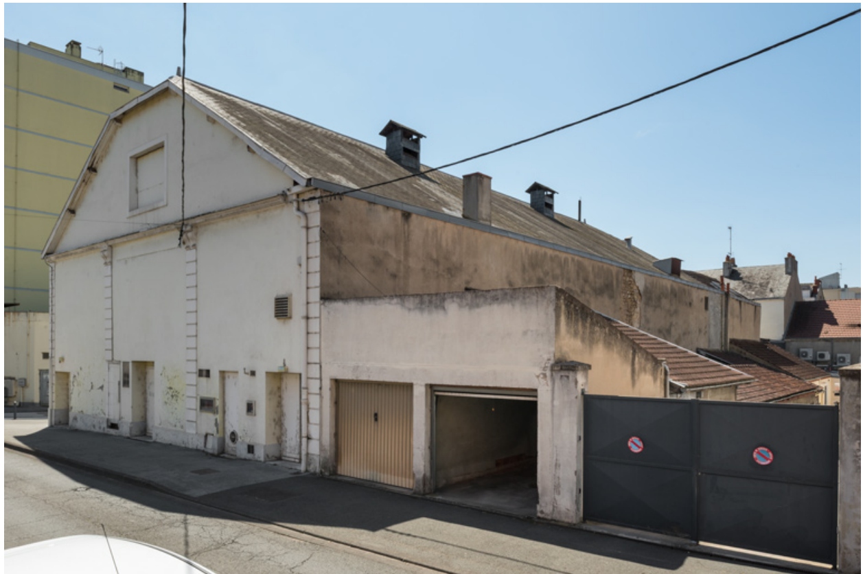
Cinéma : façades postérieure et latérale droite.
