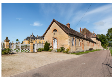
Dépendances, vues de la route au sud.
