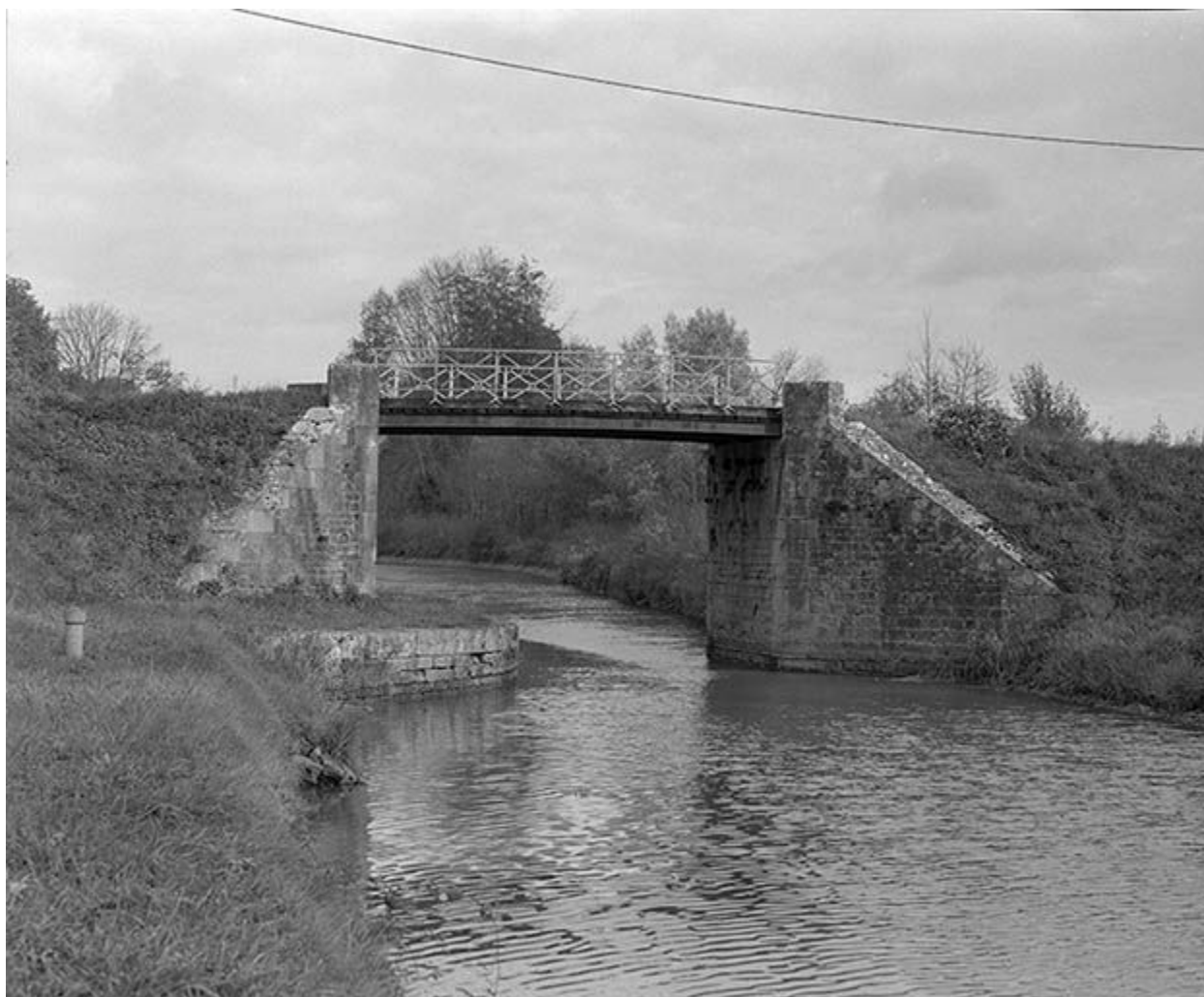
Vue prise depuis le chemin de halage, de l'amont.
