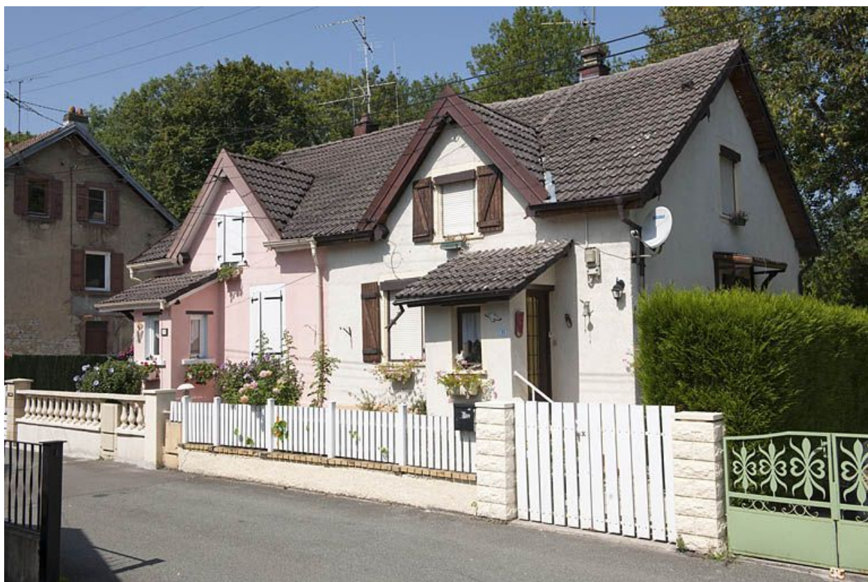
Maison jumelée rue des Campenottes.
