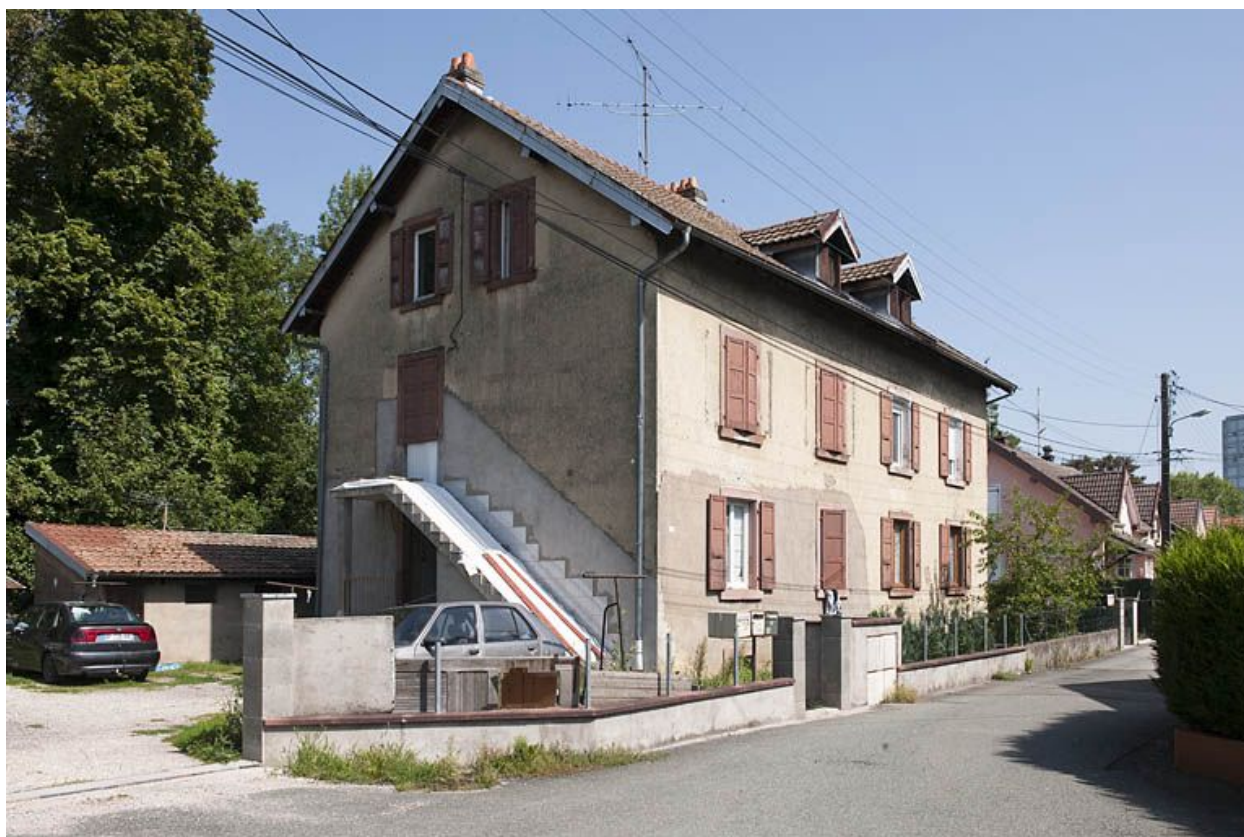
Habitation à quatre logements rue des Campenottes.
