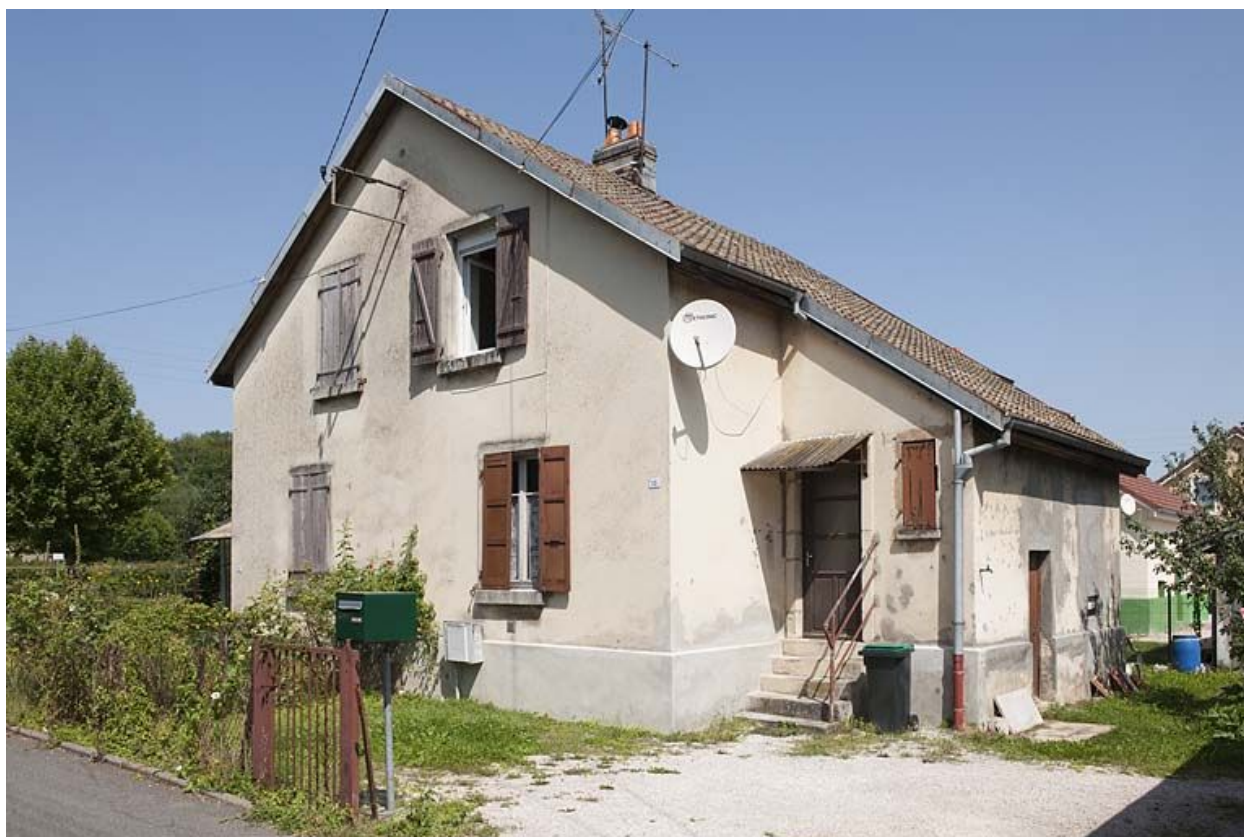
Maison jumelée vue de trois quarts droite.
