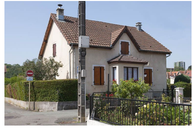
Maison individuelle. Phot. Jérôme Mongreville IVR43_20112502213NUC4A
