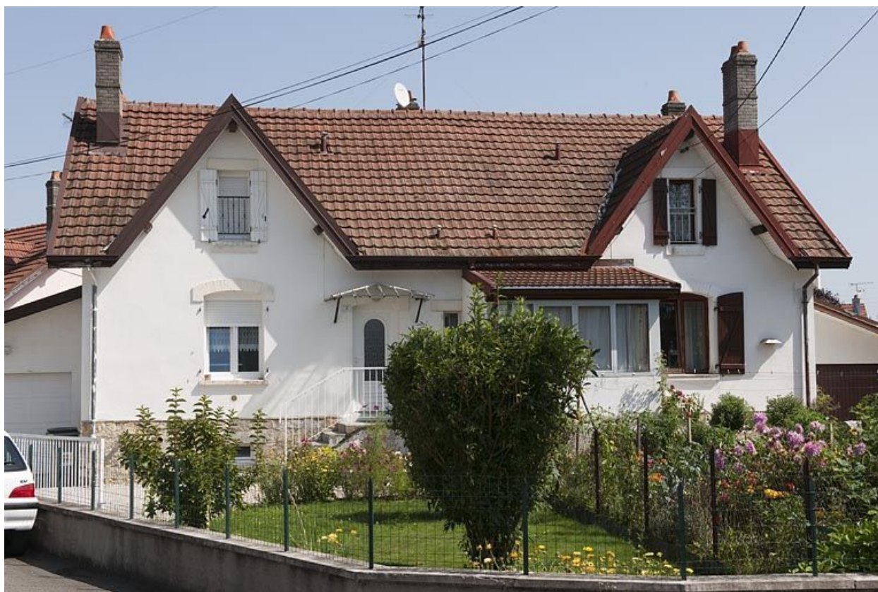
Maison jumelée. Vue de face.
