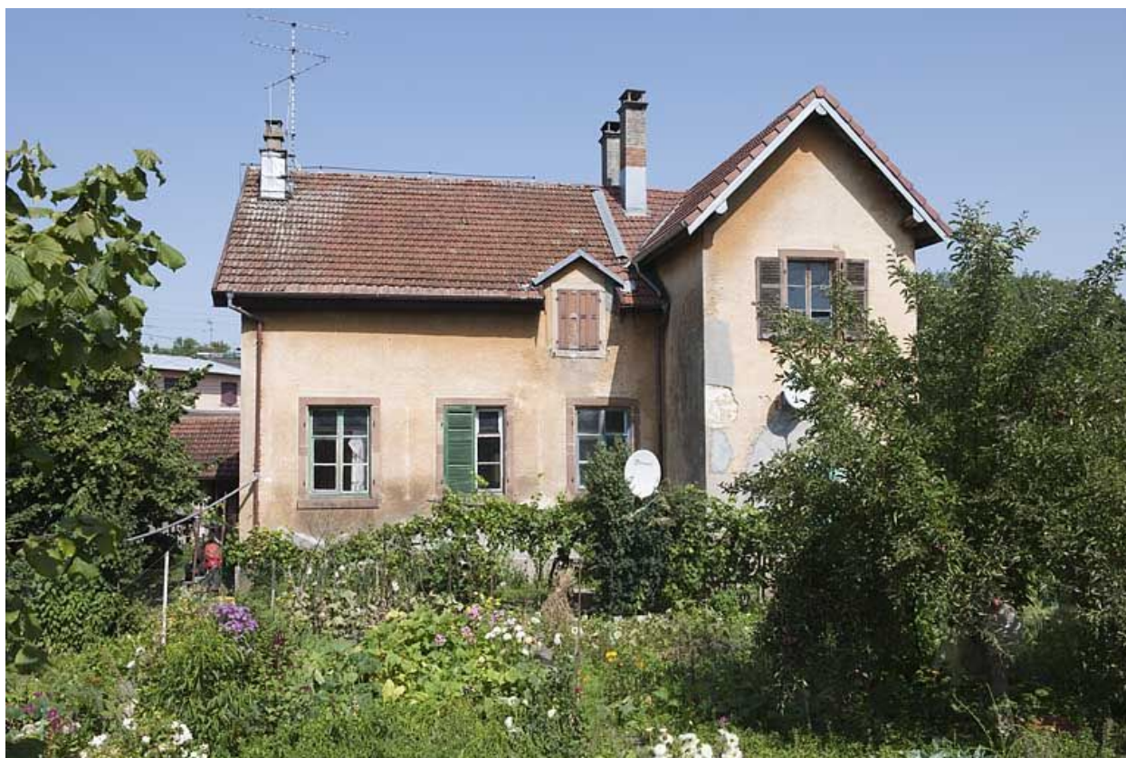
Façade sud de l'école.
