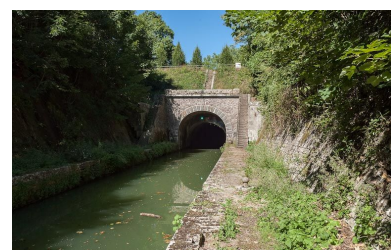
Vue de l'entrée du tunnel à Créancey. Phot. Pierre-Marie Barbe-Richaud IVR26_20122101890NUC4AQ
