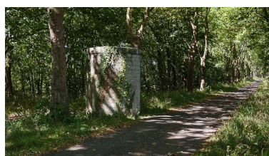
Vue d'un puits d'aérage du tunnel. Phot. Pierre-Marie Barbe-Richaud IVR26_20122101897NUC2AQ
