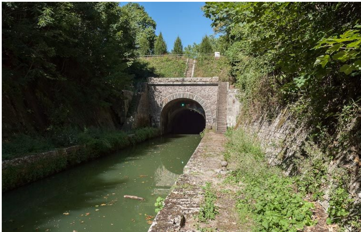
Vue de l'entrée du tunnel à Créancey.
