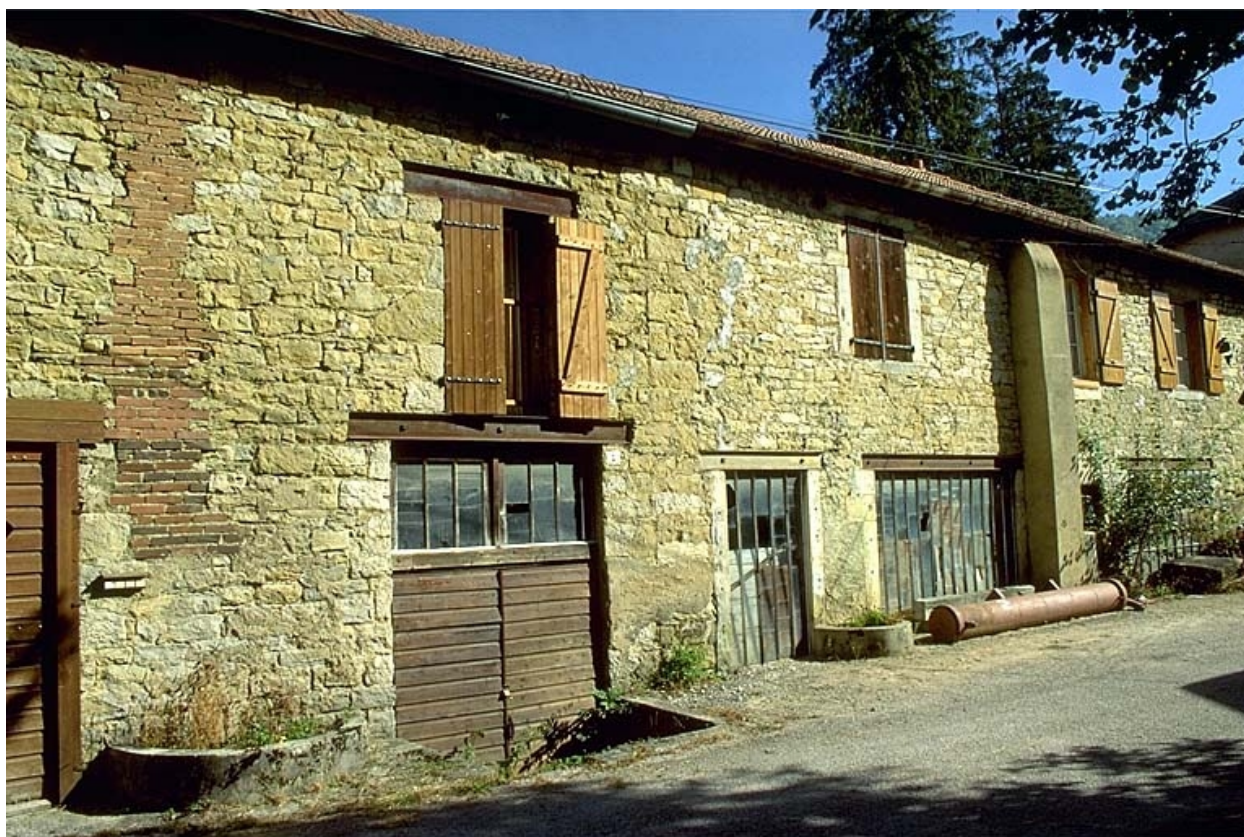
Façade antérieure de l'atelier de fabrication.
