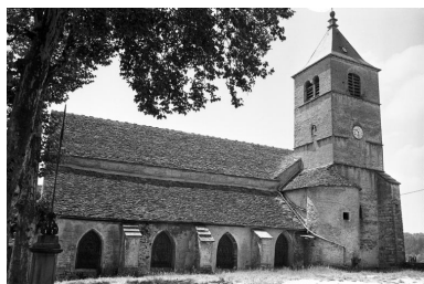
Façade latérale gauche. Phot. Guy Forestier IVR43_19743900681Z
