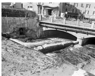
Seuil et muret précédant la pile. Noter dans le mur gauche le débouché du canal et celui de l'égout (sous l'arche).
