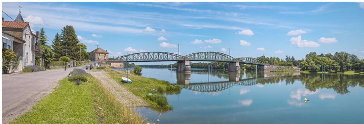
Pont et quai à gradins de Fleurville.
