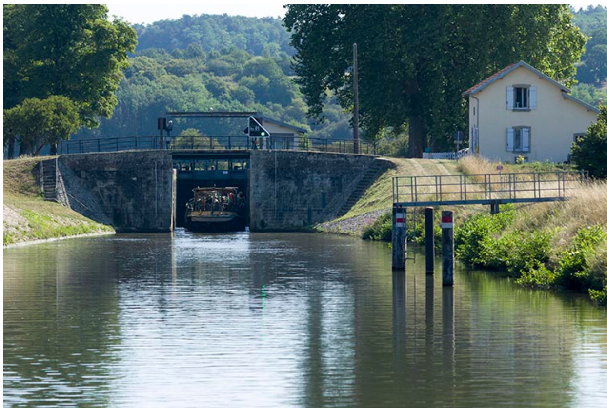
Site d'écluse, Ormoy.
