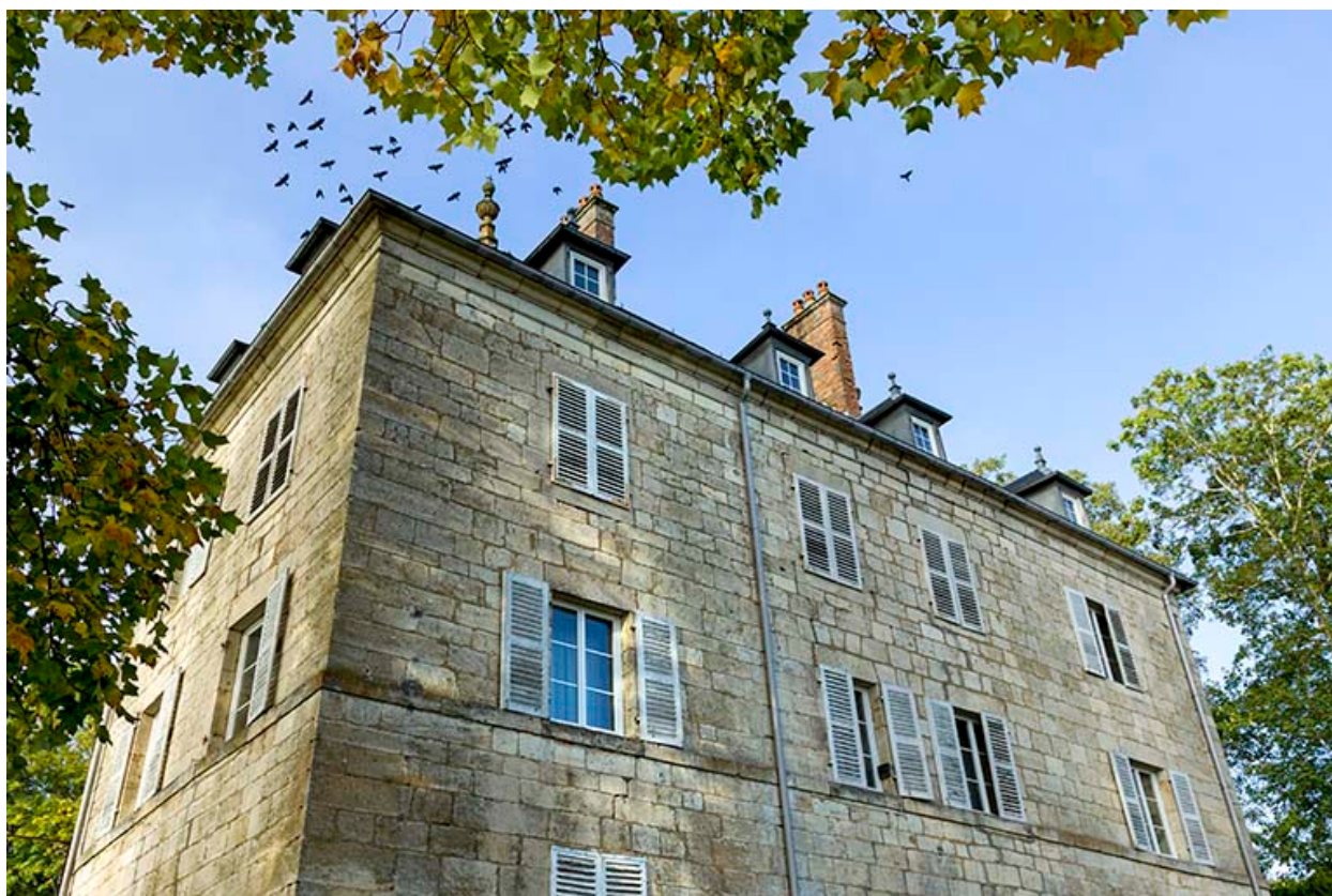
Façade postérieure et façade latérale droite.
