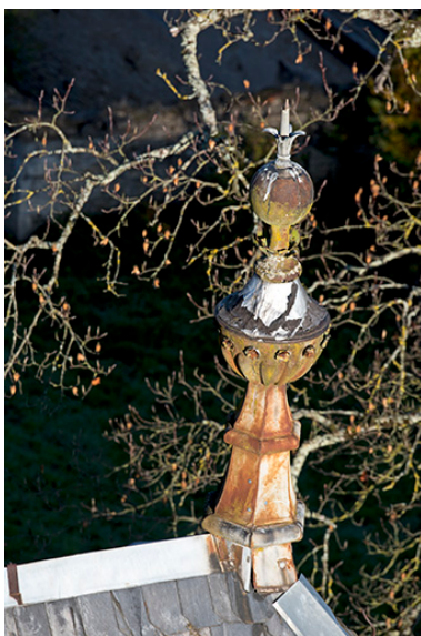
Détail : un des épis de faîtage.
