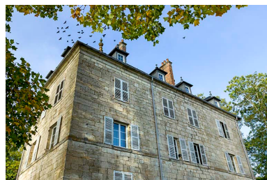
Façade postérieure et façade latérale droite.
