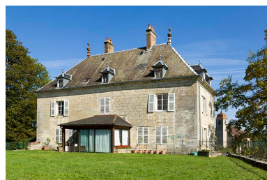
Façade antérieure et façade latérale droite.
