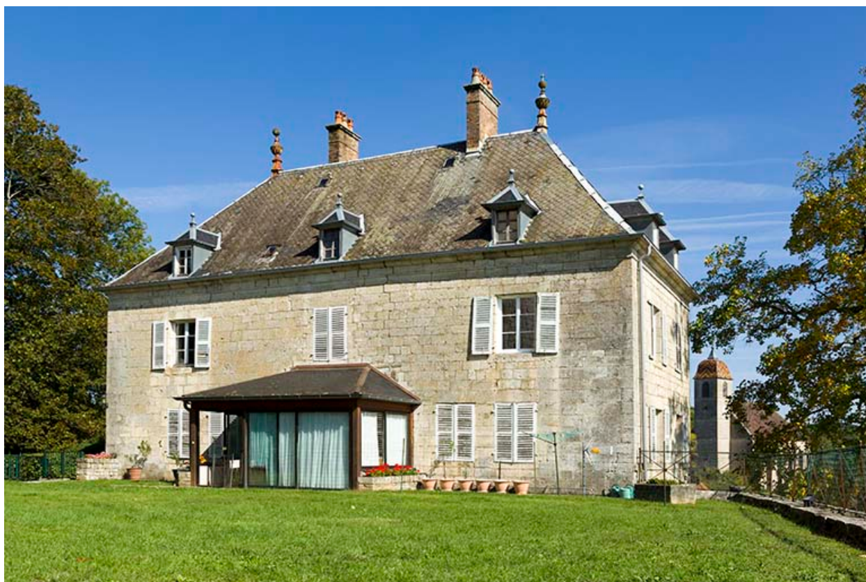
Façade antérieure et façade latérale droite.
