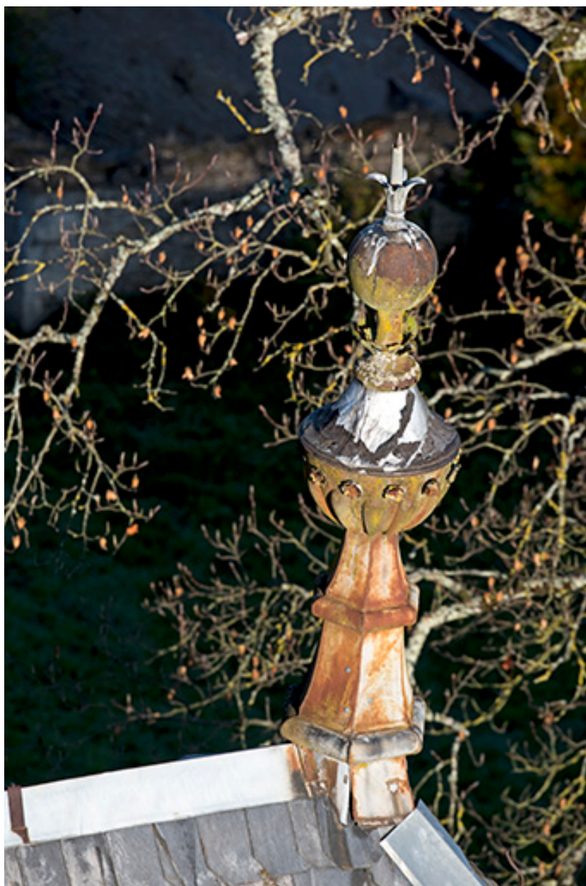
Détail : un des épis de faîtage.
