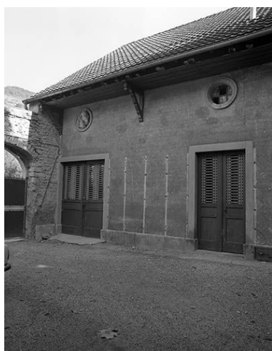
Façade antérieure de l'écurie. Phot. Yves Sancey IVR43_19802501394X
