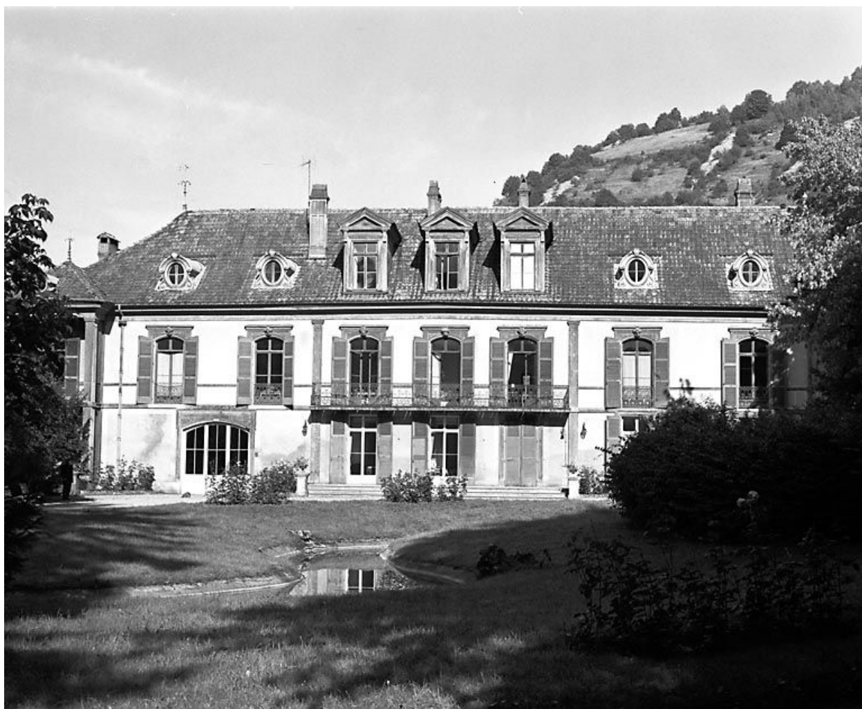
Façade postérieure vue depuis le parc.
