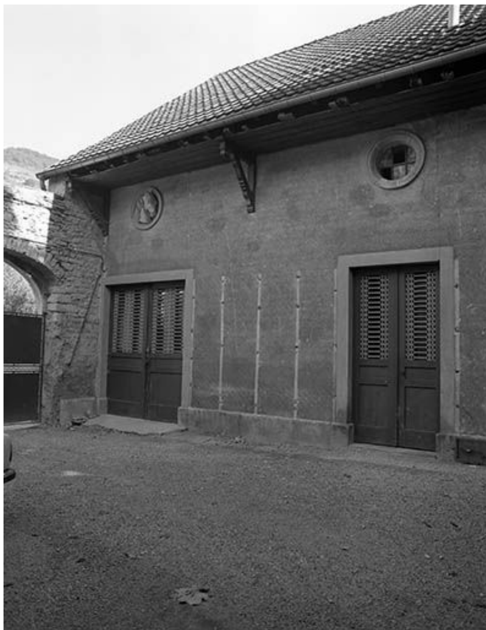
Façade antérieure de l'écurie.
