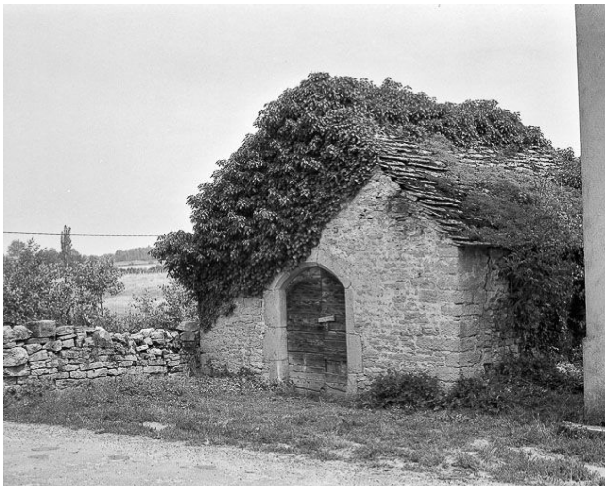
Chapelle située au lieudit Beyne.
