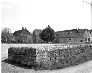
Vue générale. Phot. Bernard Lardière IVR43_19793900291X
