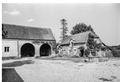
Bâtiment d'exploitation. Phot. Guy Forestier IVR43_19753900136Z
