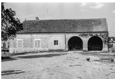
Bâtiment d'exploitation. Phot. Guy Forestier IVR43_19753900134Z
