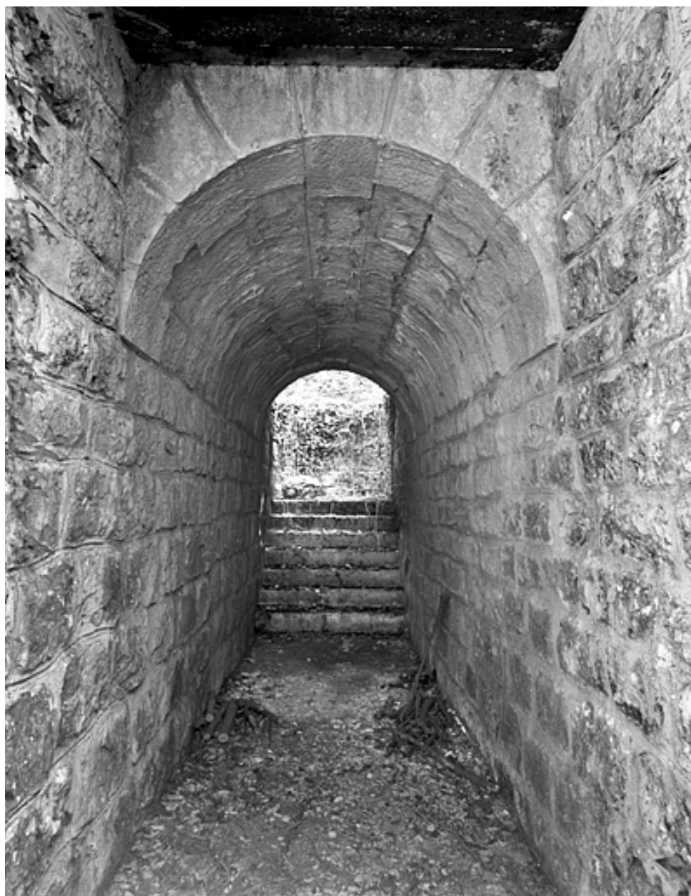
Passage et voûte, depuis l'ouest.
