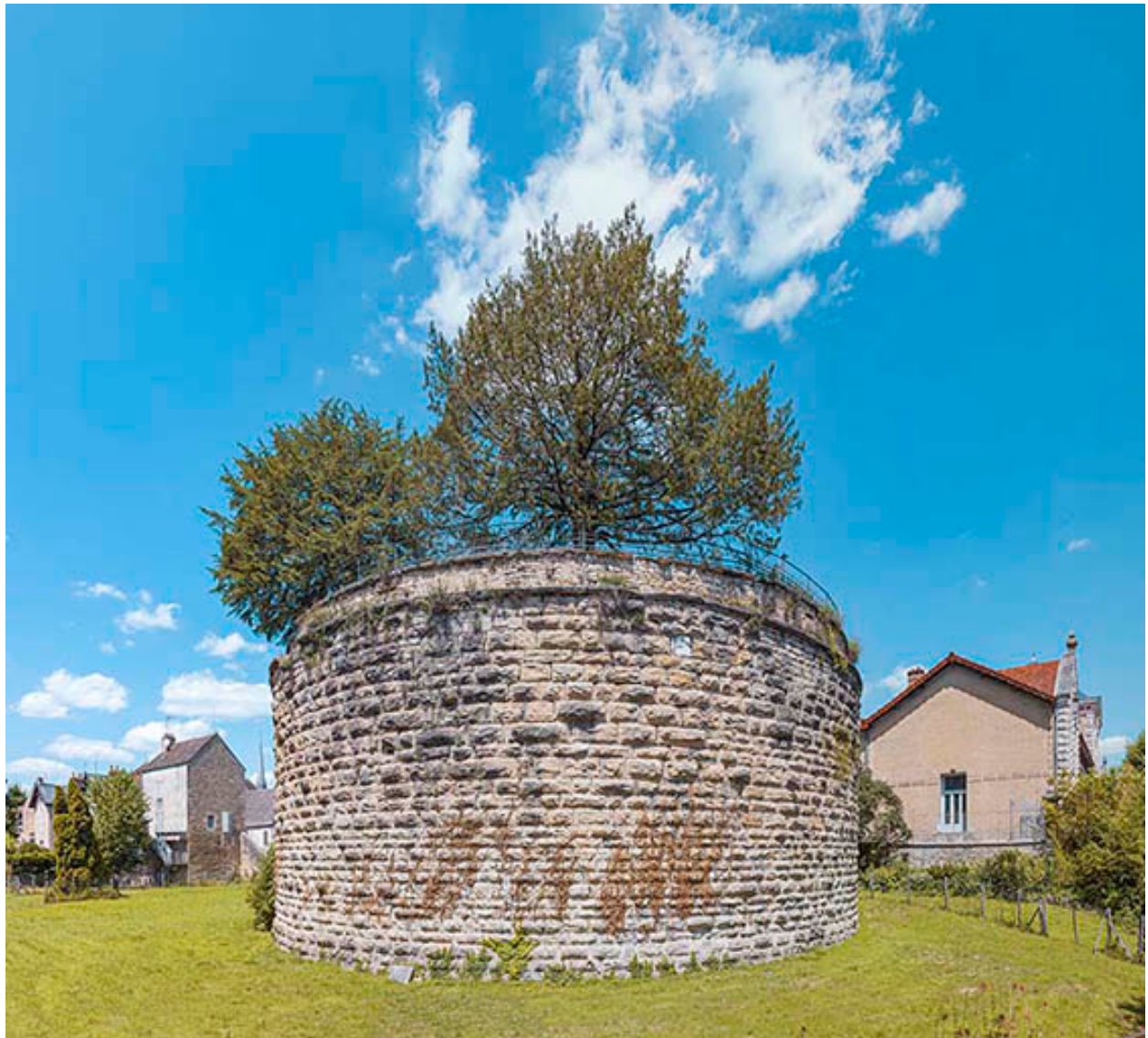
La tour depuis le fossé.
