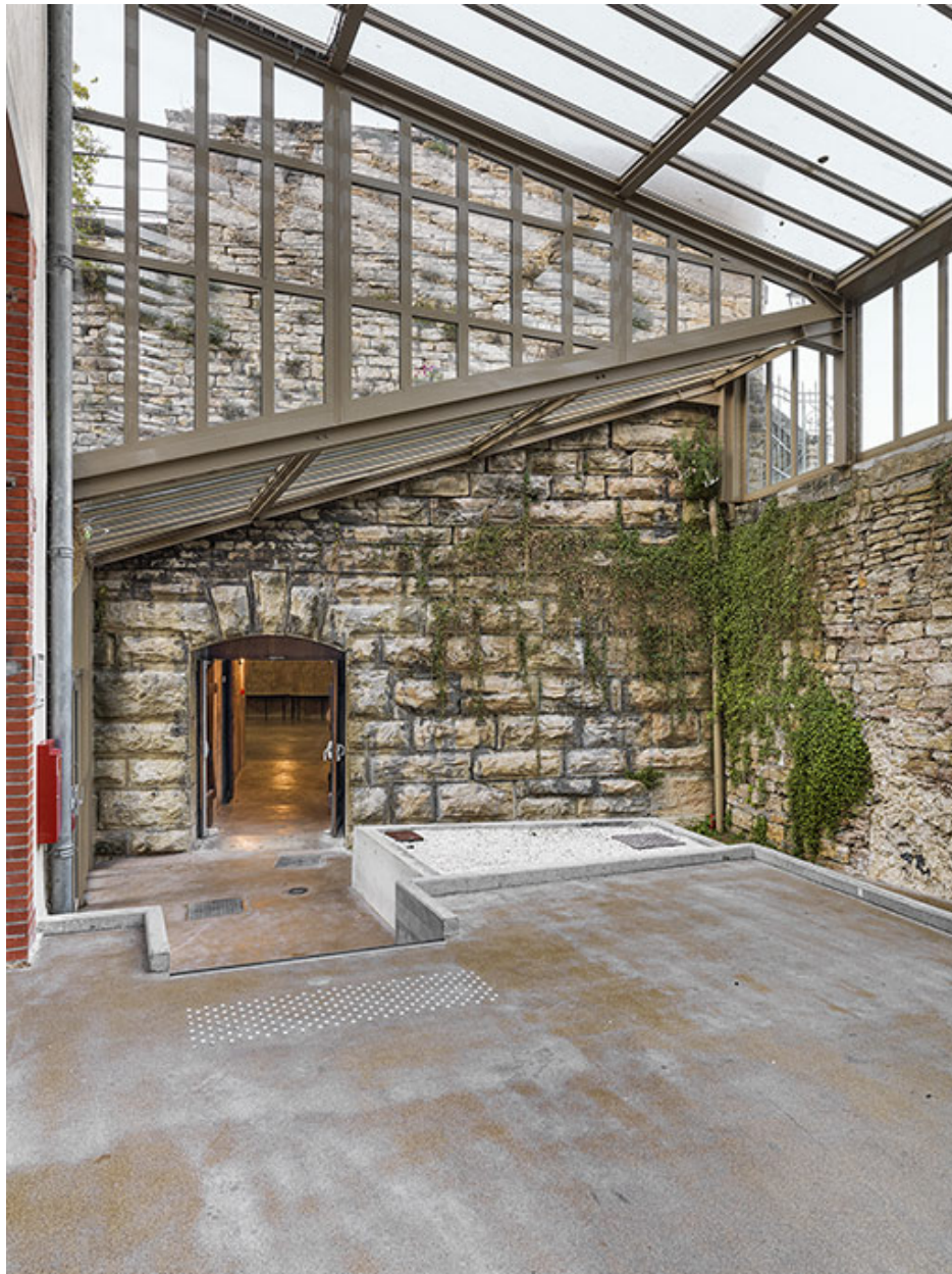
Détail de la maçonnerie et porte d'entrée.
