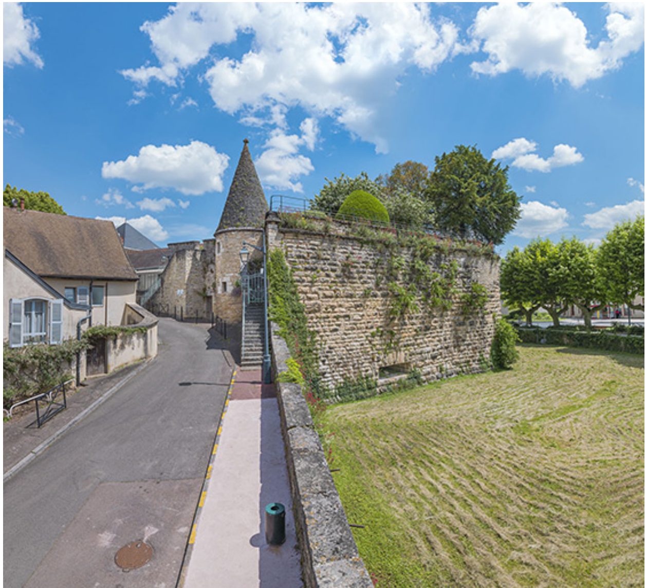
La tour, vue depuis celle des Bouchers.
