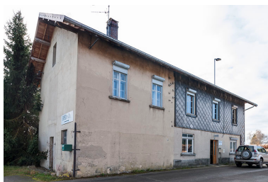
Bureau (et logement). Phot. Jérôme Mongreville IVR43_20152502397NUC4A
