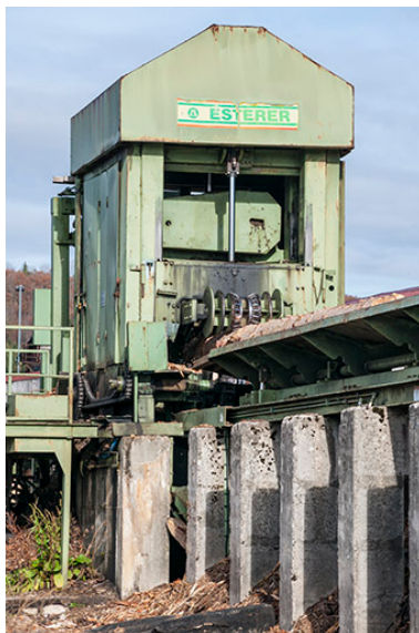
Poste d'écorçage. Phot. Jérôme Mongreville IVR43_20152502391NUC4A
