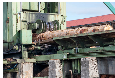
Détail du poste d'écorçage. Phot. Jérôme Mongreville IVR43_20152502390NUC4A
