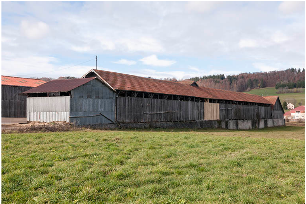
Hangars de stockage.
