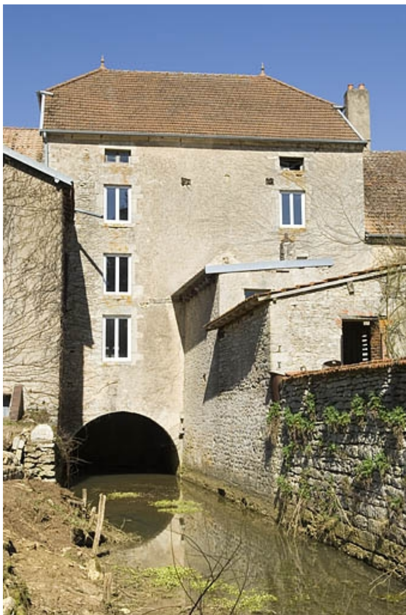
Façade postérieure depuis le bief d'aval.
