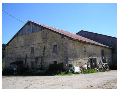
Ferme située aux Janiers. Phot. Marie-Pierre Reynet IVR43_20083900299NUC1A
