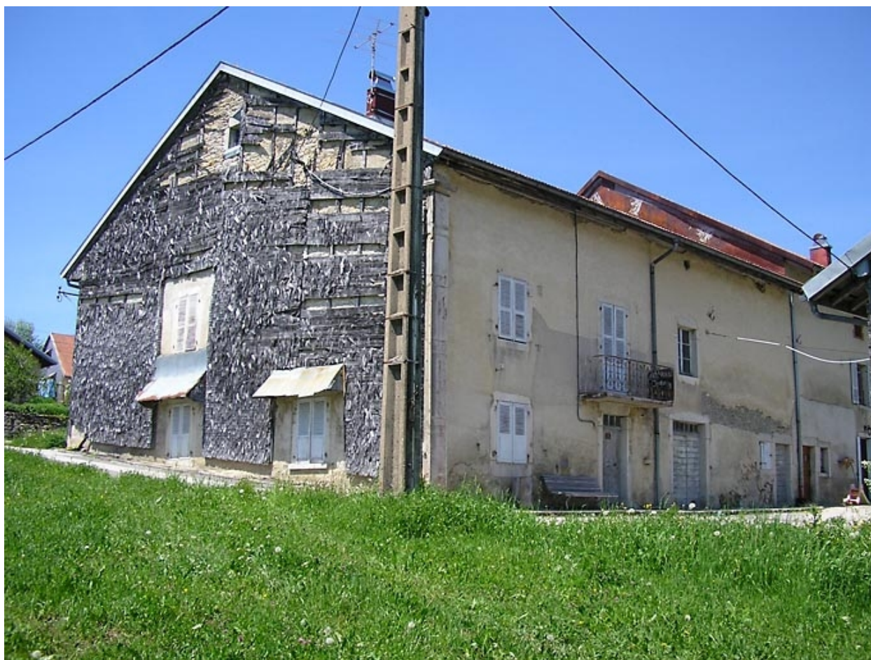
Ferme située au lieu-dit Prénovel de Bise.
