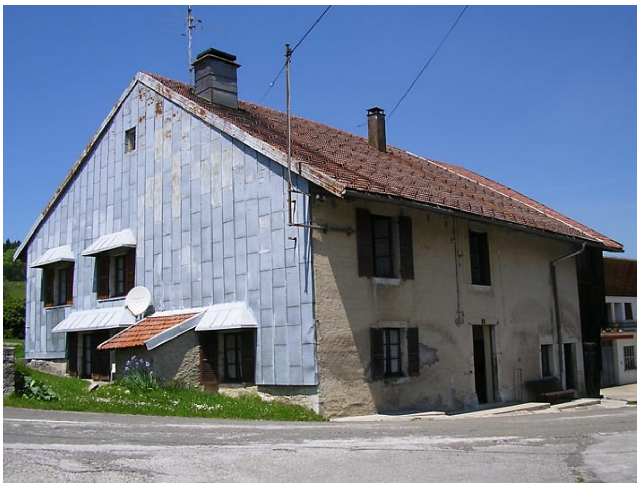
Ferme située au lieu-dit Prénovel de Bise.
