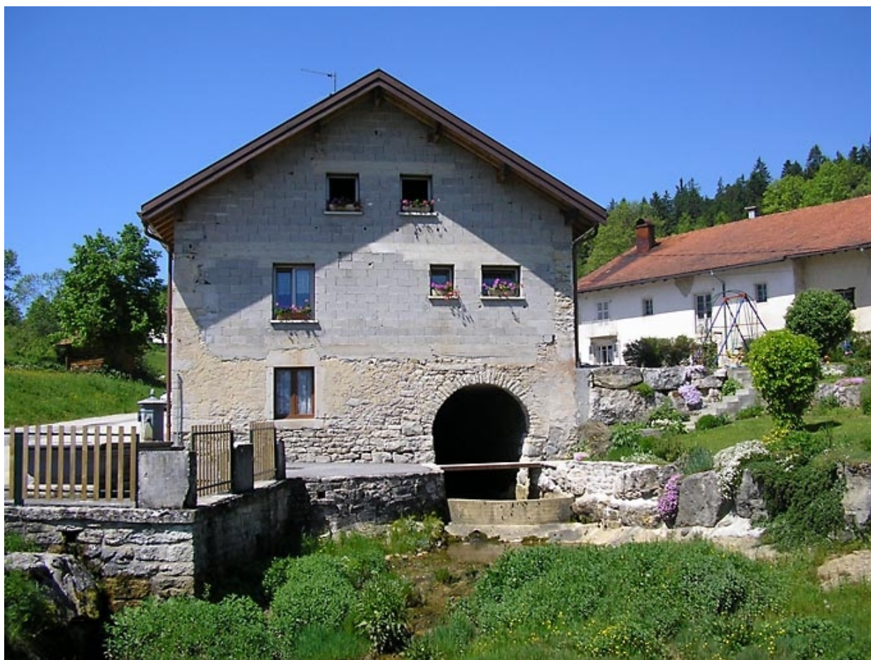
Scierie située au lieu-dit les Belbenoîts.
