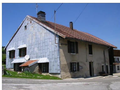
Ferme située au lieu-dit Prénovel de Bise. Phot. Marie-Pierre Reynet IVR43_20083900338NUC1A
