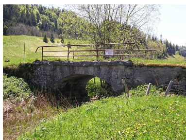
Pont situé au lieu-dit les Fans. Phot. Marie-Pierre Reynet IVR43_20083900288NUC1A
