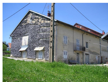
Ferme située au lieu- dit Prénovel de Bise. Phot. Marie-Pierre Reynet IVR43_20083900342NUC1A
