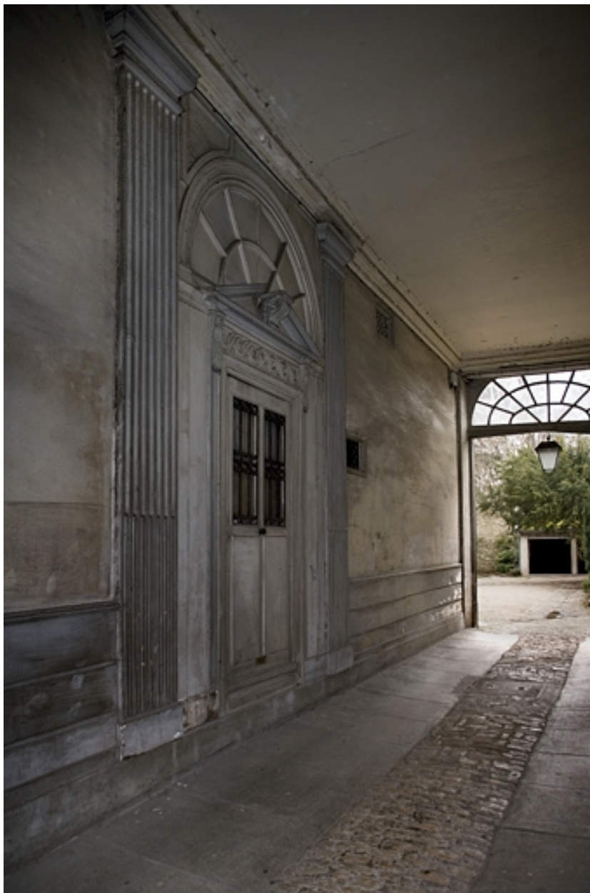
Vue de l'entrée sous le passage cocher.
