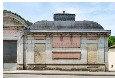
Elévation sur rue du pavillon nord. Phot. Jérôme Mongreville IVR43_20233900673NUC4A
