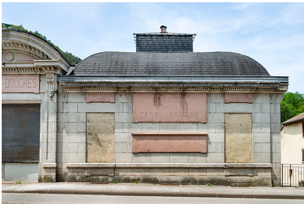
Elévation sur rue du pavillon nord.
