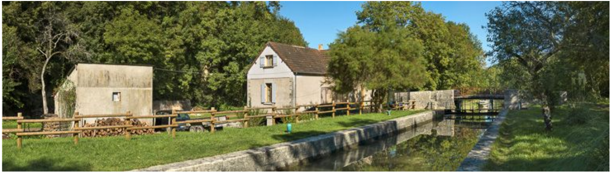
Vue d'ensemble du site écluse.
