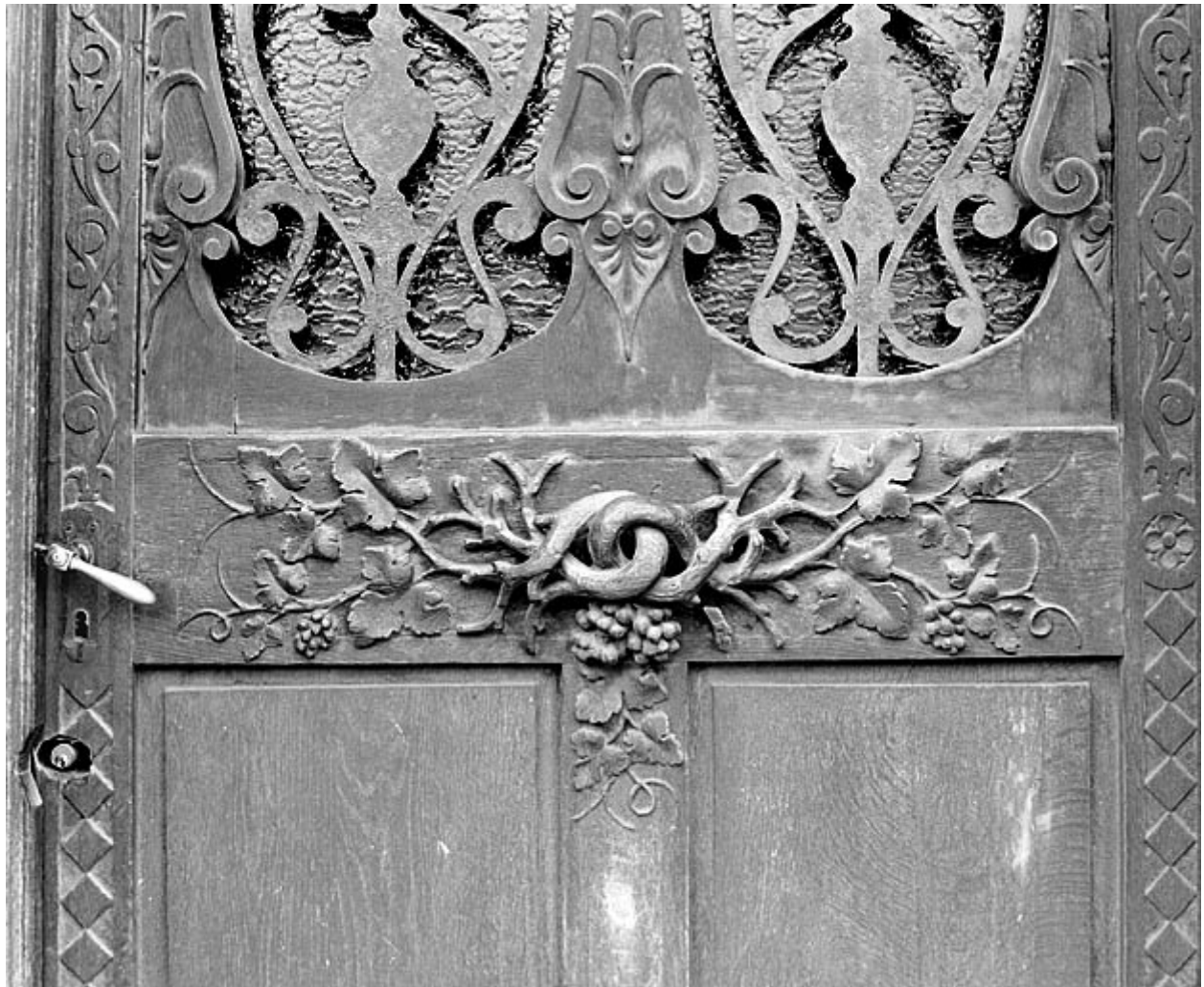
Détail de la porte d'entrée.
