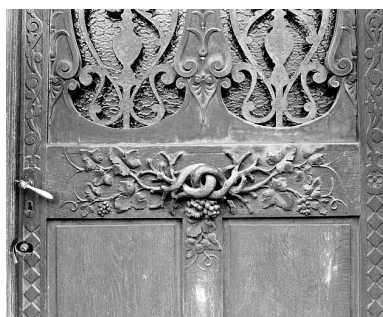
Détail de la porte d'entrée. Phot. Jérôme Mongreville IVR43_19872500800X
