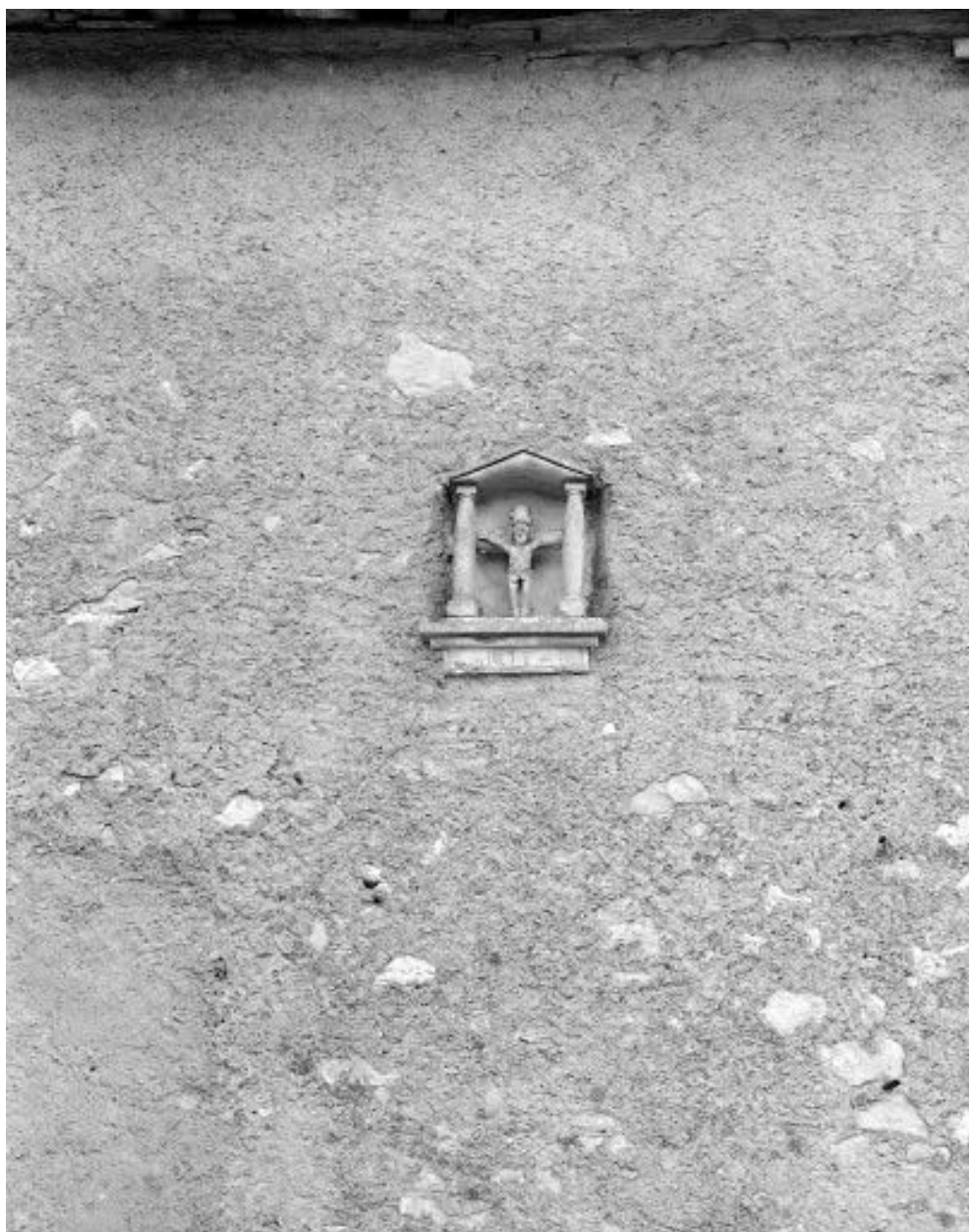
Ferme située rue Principale : détail de la façade (Christ en croix daté 1871).
