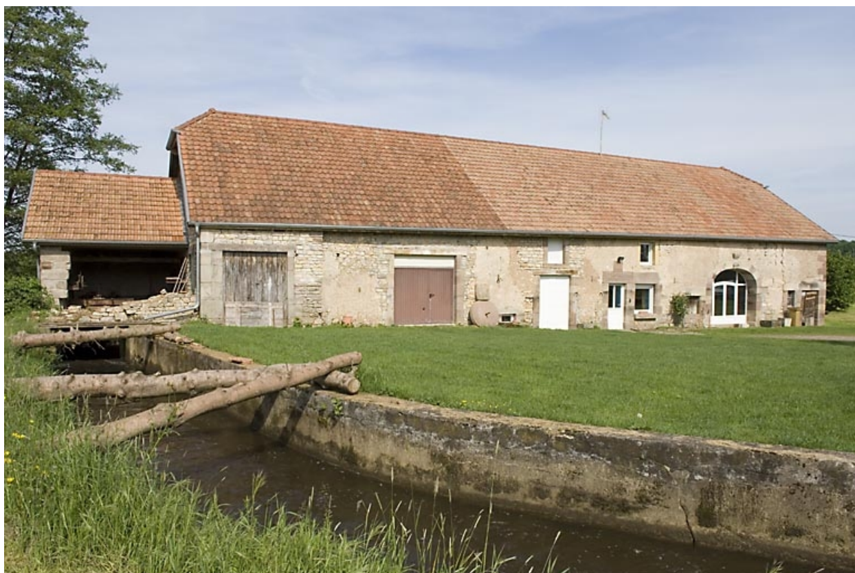
Bief d'amenée et façade antérieure.
