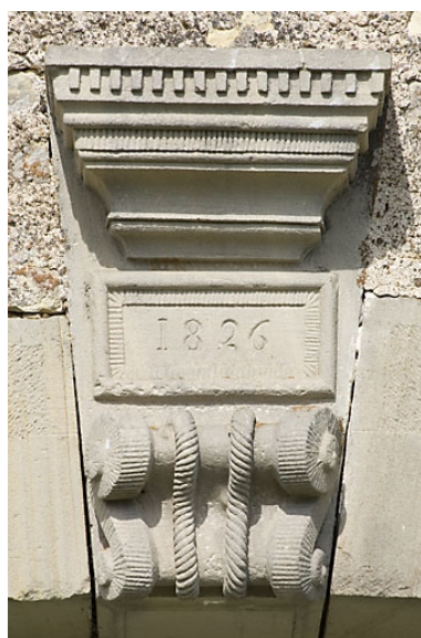
Arcade de la grange. Détail de la clef. Phot. Jérôme Mongreville IVR43_20077000151NUCA
