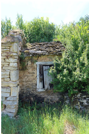
Vue du puits. Phot. Morgane Guillemain IVR26_20222101169NUC2A
