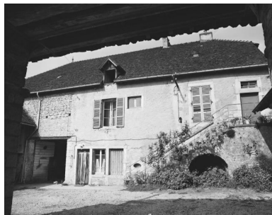
Façade antérieure. Phot. Dominique Dominguez IVR43_19803900062X
