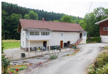
Site de la scierie : logement d'ouvriers. Phot. Yves Sancey IVR43_20132501308NUC2A
