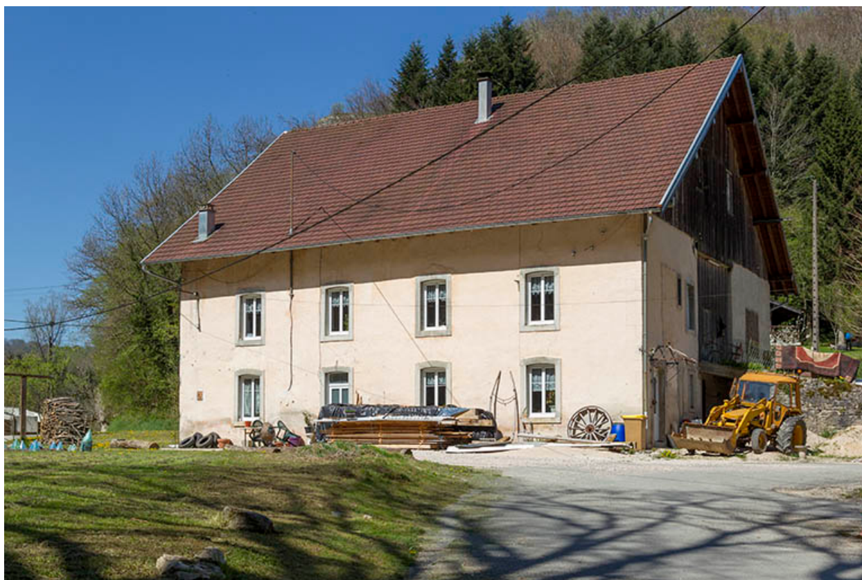
Site du moulin : logement d'ouvriers, depuis l'ouest.
