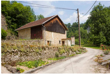
Site de la scierie : remise et étable. Phot. Yves Sancey IVR43_20132501311NUC2A
