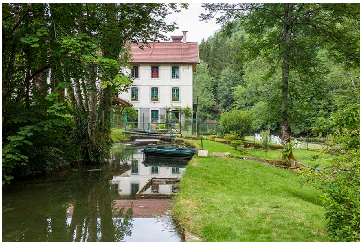
Moulin, façade antérieure : bief d'amenée.
