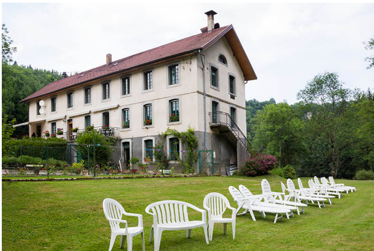
Moulin : façades antérieure et latérale droite.
