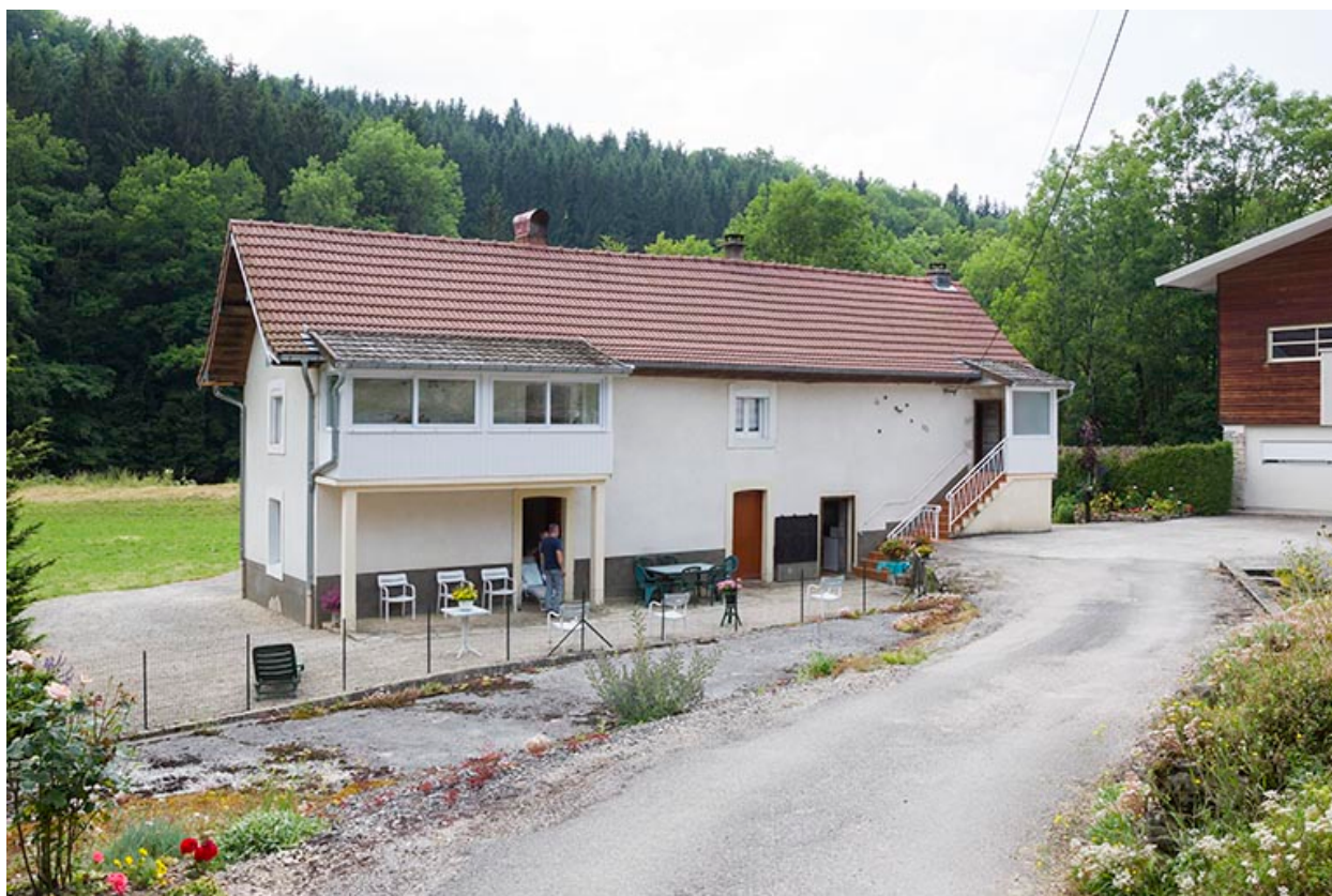
Site de la scierie : logement d'ouvriers.
