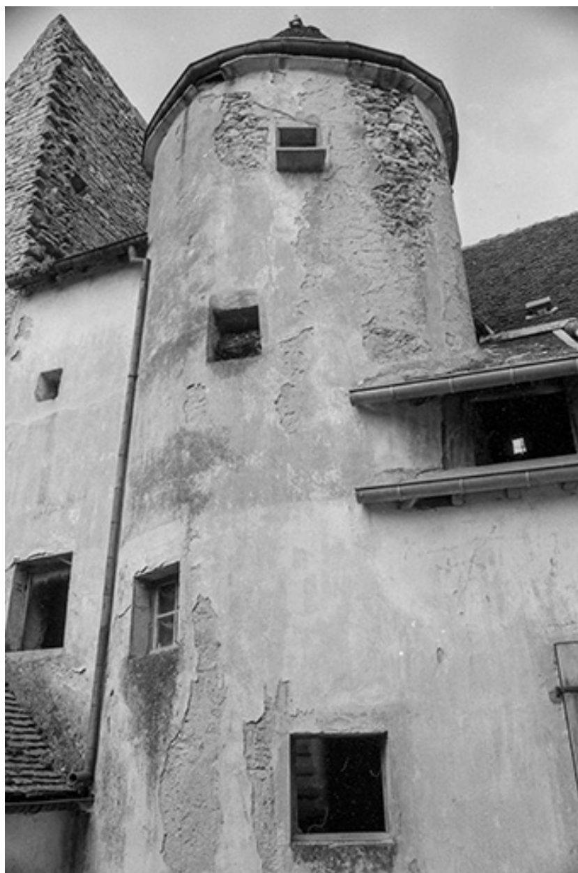
Tourelle d'escalier avec pigeonnier au dernier étage.
