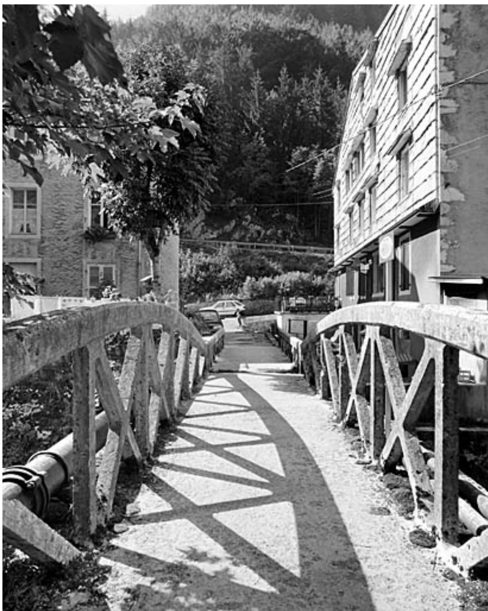
Tablier et garde-corps, depuis la rive droite.
