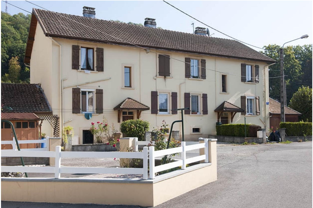
Façade antérieure d'une habitation.
