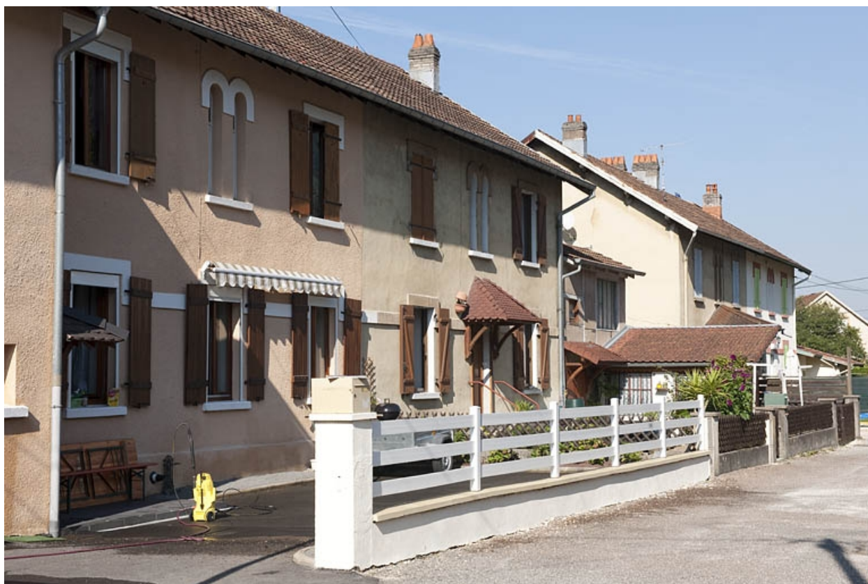
Façade antérieure d'habitations.
