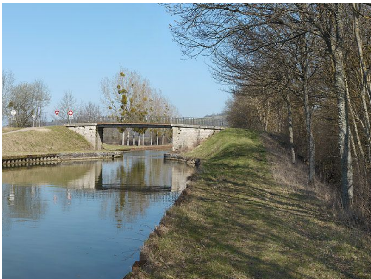
Le pont routier, vue d'ensemble.
