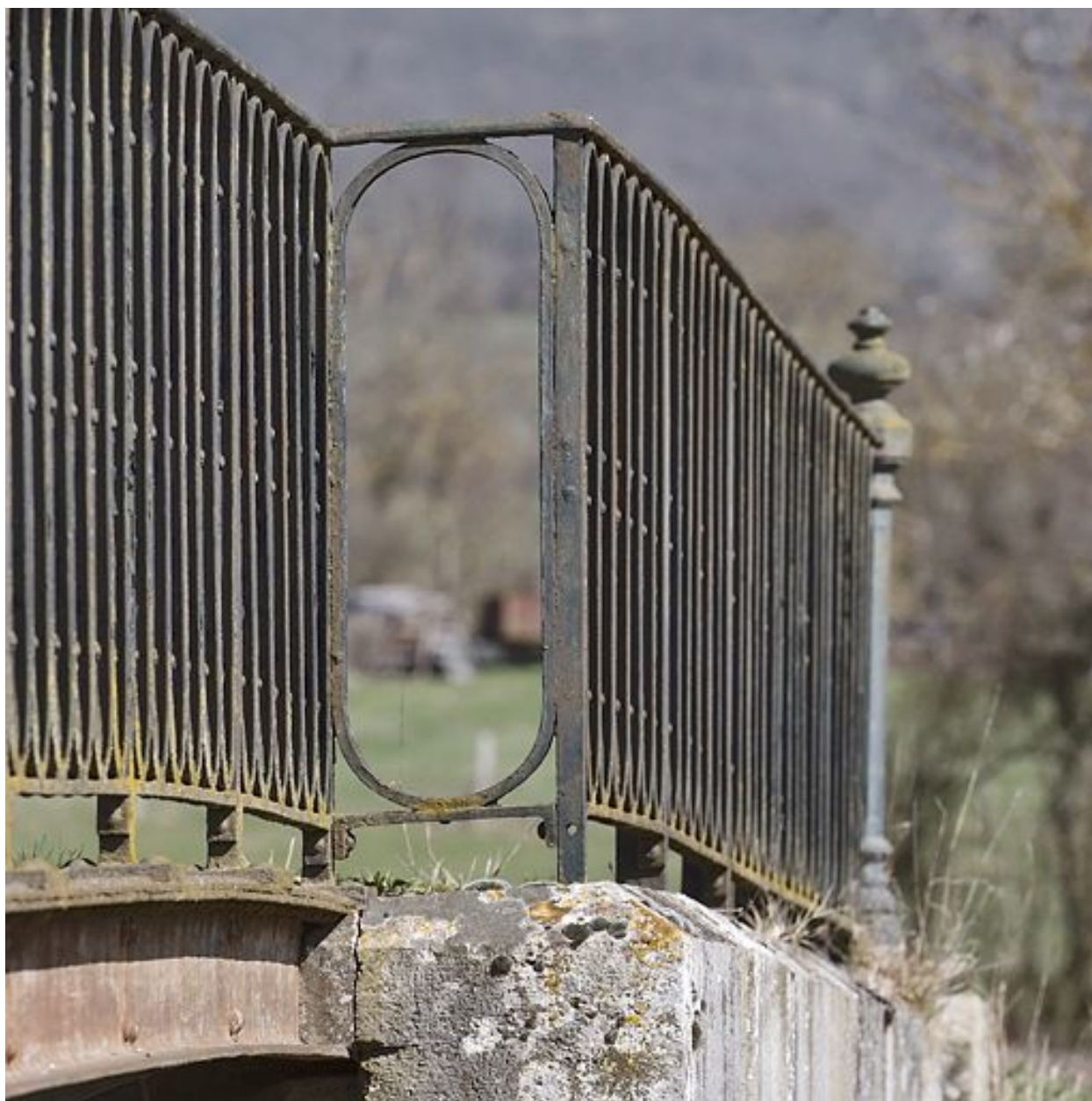
Le pont routier, détail des garde-corps.
