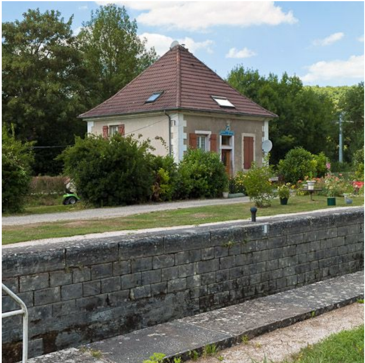
Vue d'ensemble du site d'écluse.
