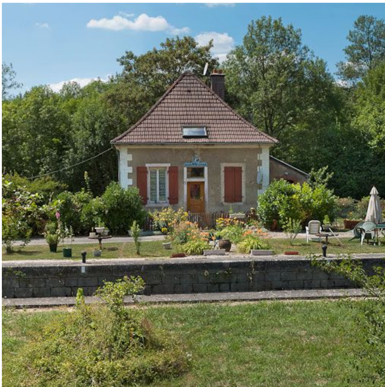
Vue de face de la maison éclusière.
