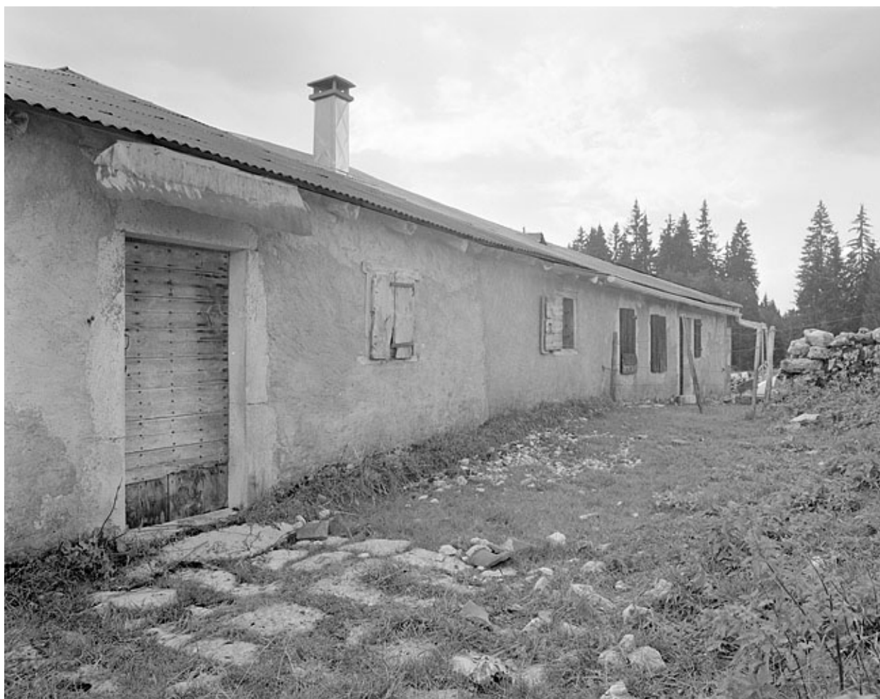
Façade postérieure, vue de trois quarts gauche.
