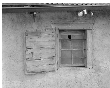
Détail d'une fenêtre. Phot. Jérôme Mongreville IVR43_19963901364X
