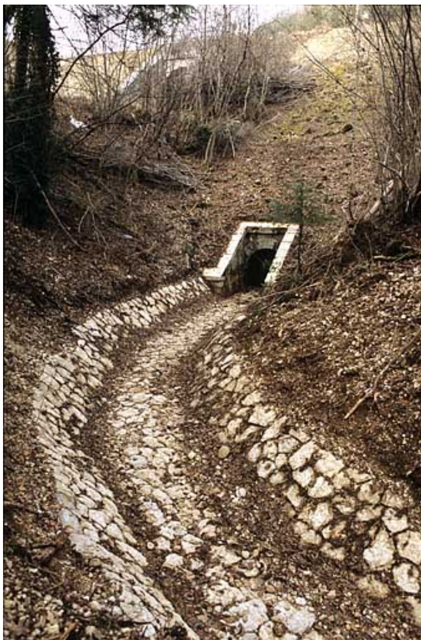
Aqueduc : tête aval (ouest) et rigole.
