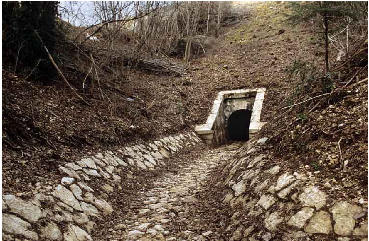
Aqueduc : tête aval et rigole (cadrage horizontal).
