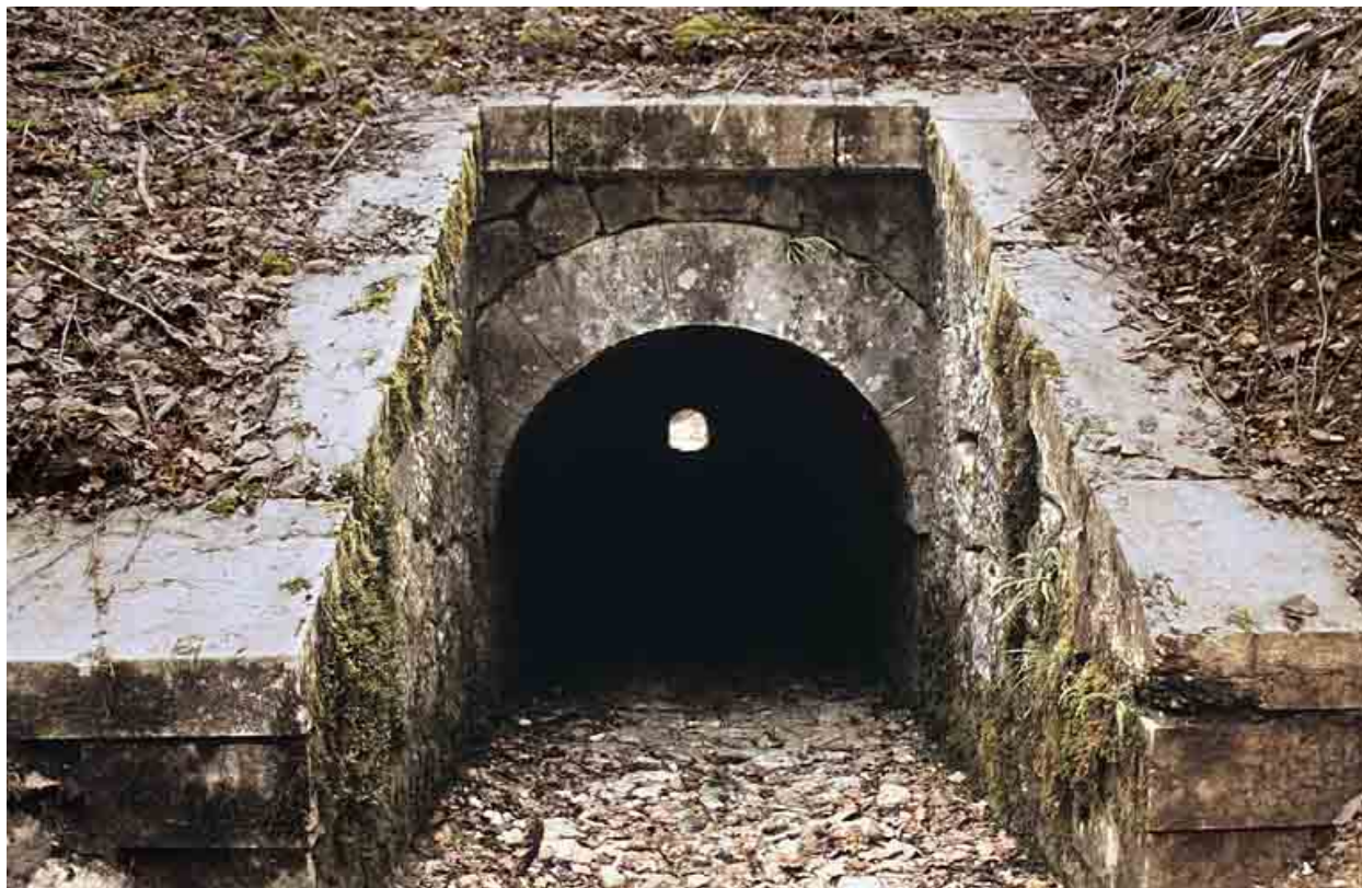
Aqueduc : tête amont (est).
