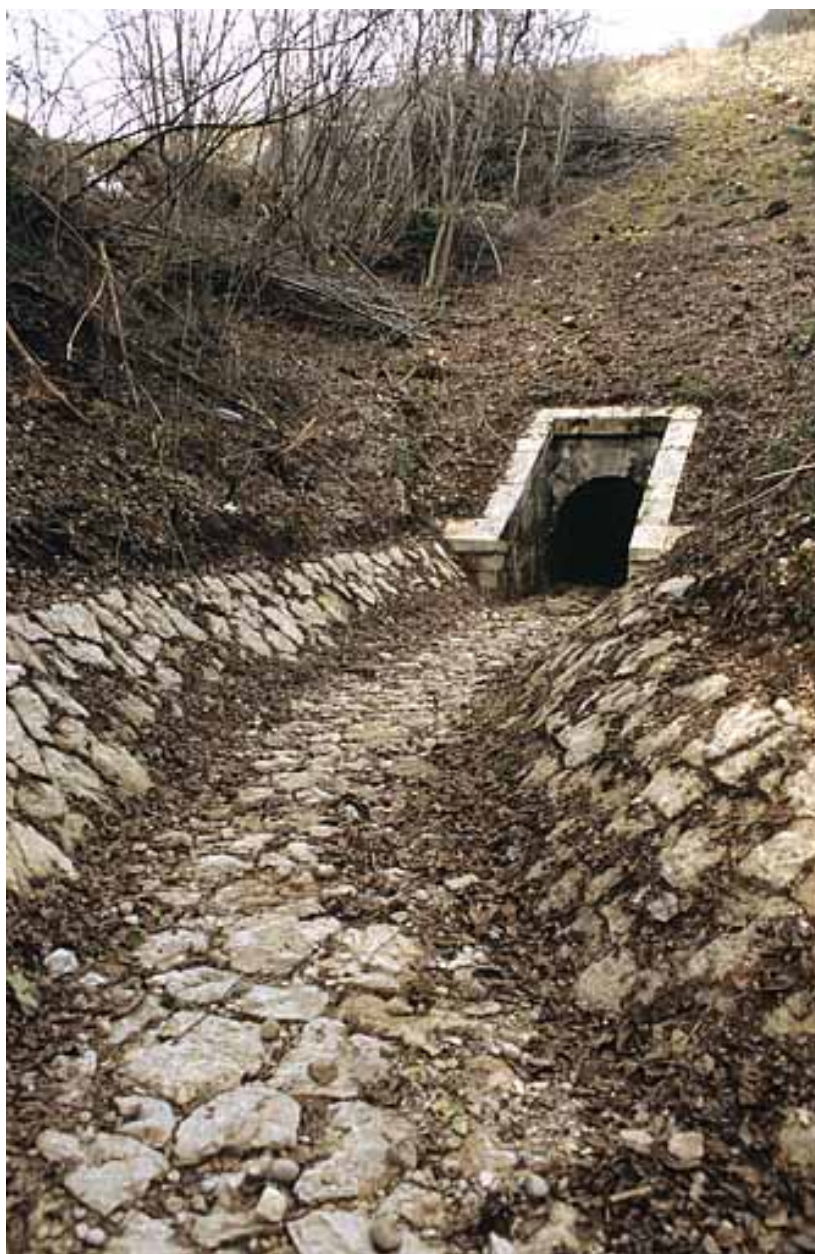
Aqueduc : tête aval (ouest) et rigole (cadrage vertical).
