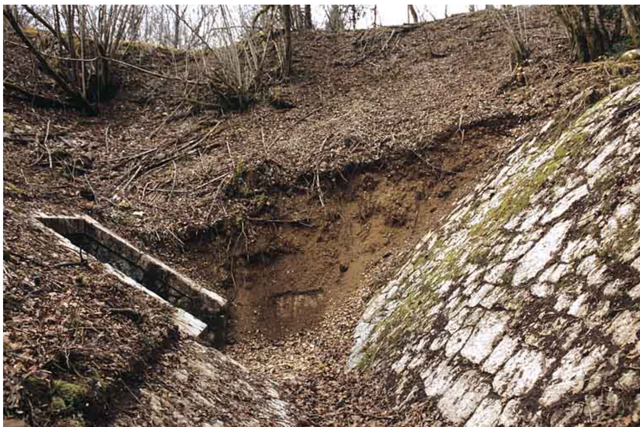
Aqueduc : " canal " et tête amont.
