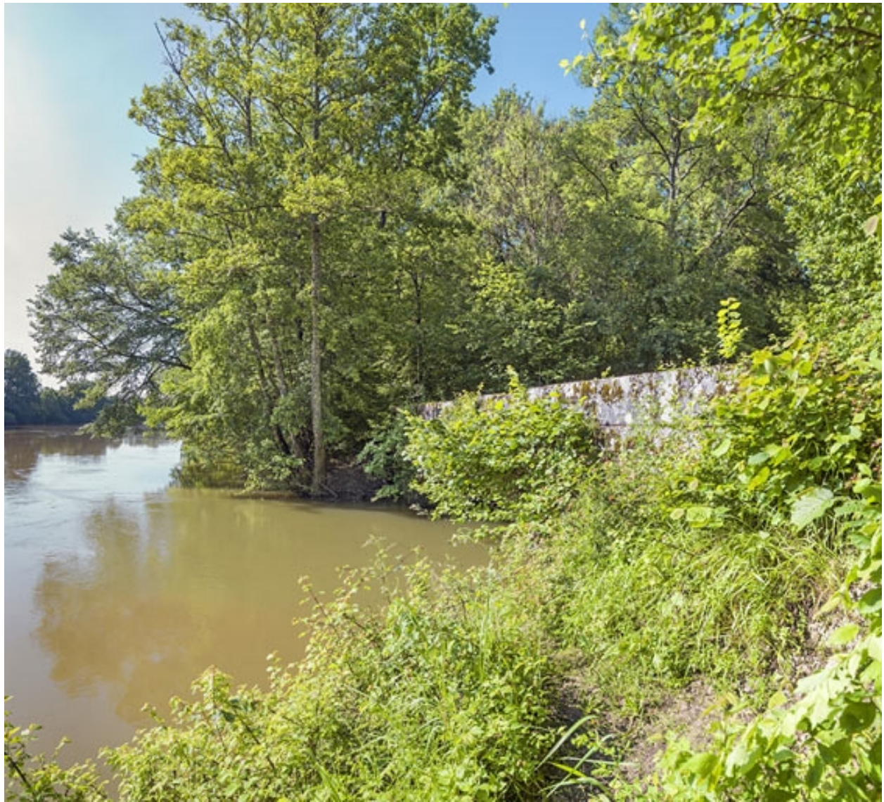
Le pont, vu depuis la Saône.
