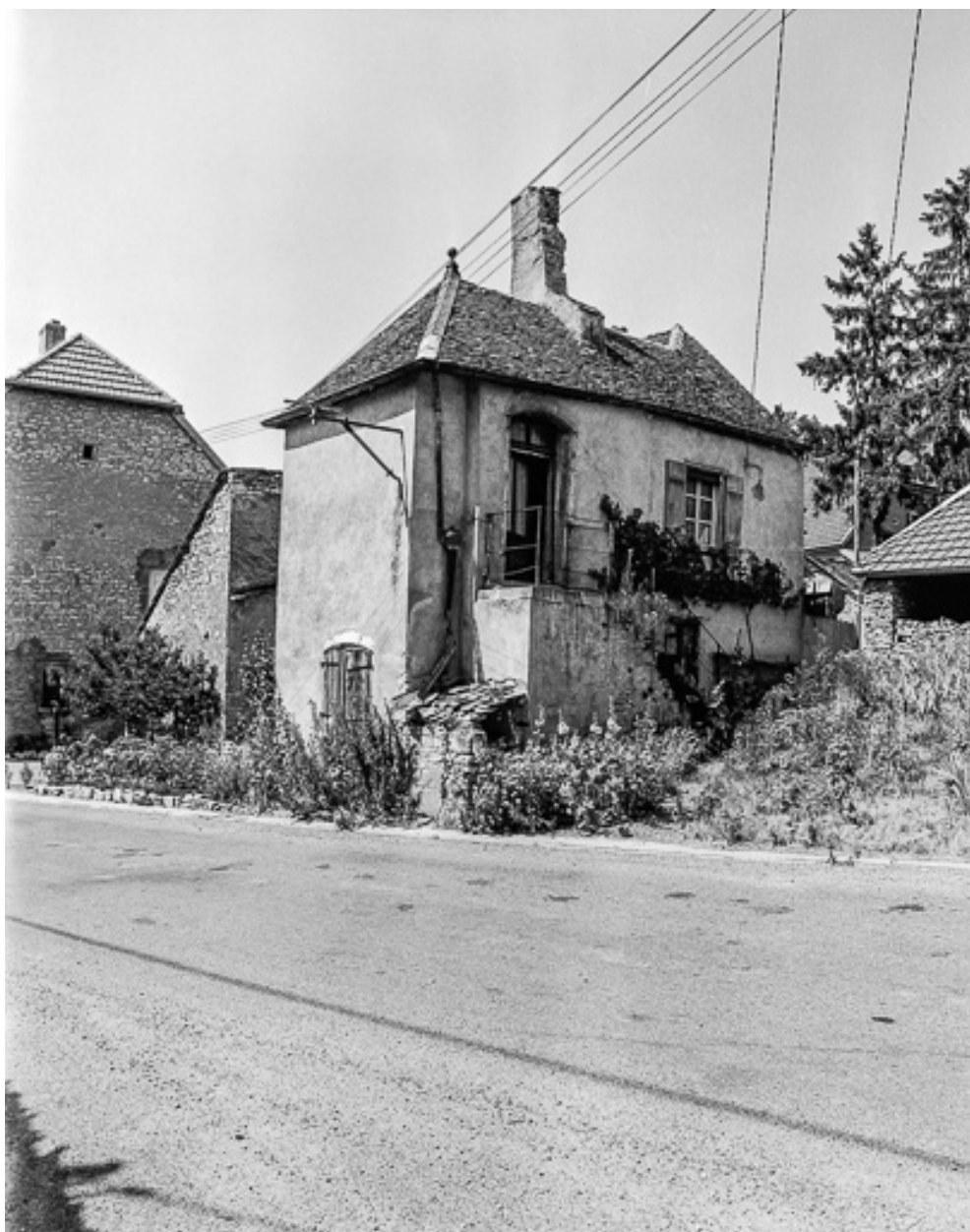
Maison située rue de Marnay : façades antérieure et latérale gauche.
