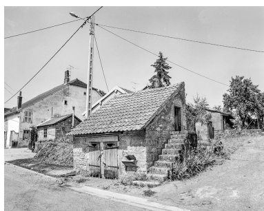
Maison située rue d'Amont à Chenevrey : la porcherie. Phot. Dominique Humbert IVR43_19767000461X
