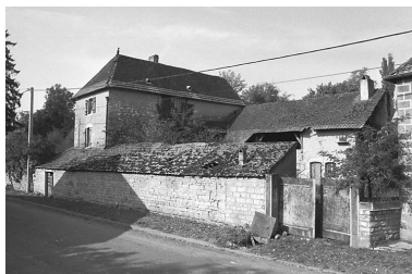
Maison de vigneron située rue d'Aval à Chenevrey : vue d'ensemble. Phot. Bernard Lardière IVR43_19797000365Z
