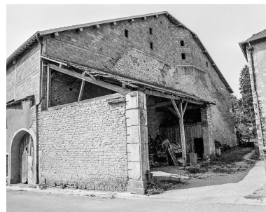
Ferme cadastrée 1973 AB 27 située rue d'Amont à Chenevrey : hangar situé à gauche de la maison. Phot. Dominique Humbert IVR43_19767000482X
