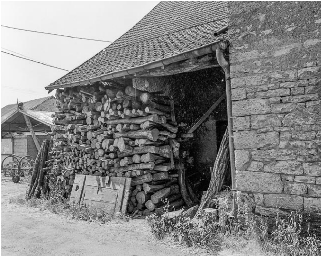
Maison située rue d'Aval à Chenevrey : façade latérale droite.
