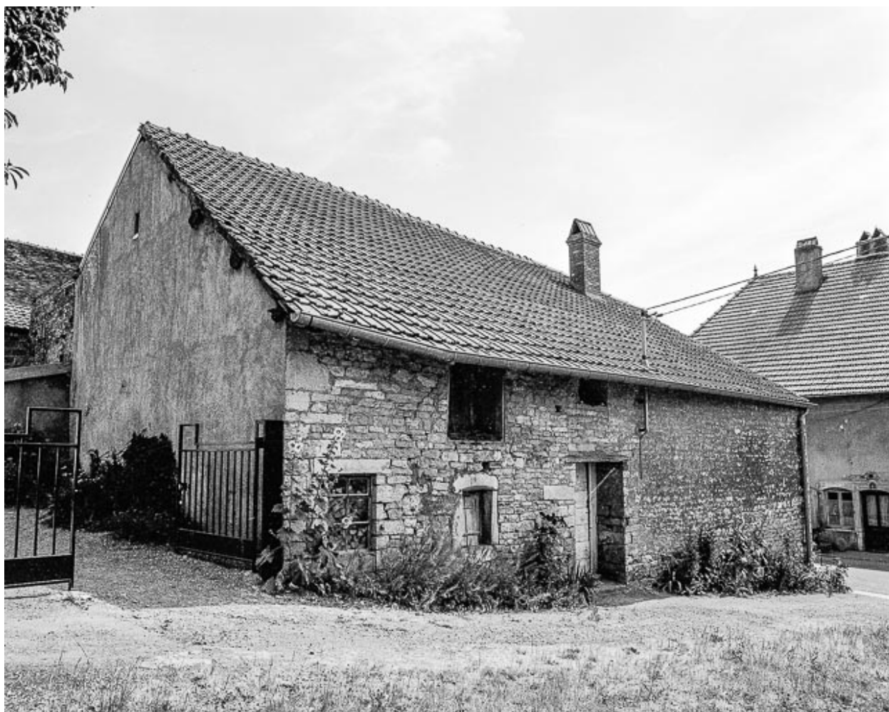
Maison située entre la rue d'Amont et la ruelle des Vignes : façade latérale gauche.
