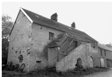
Maison située à Morogne : vue d'ensemble. Phot. Bernard Lardière IVR43_19797000351Z
