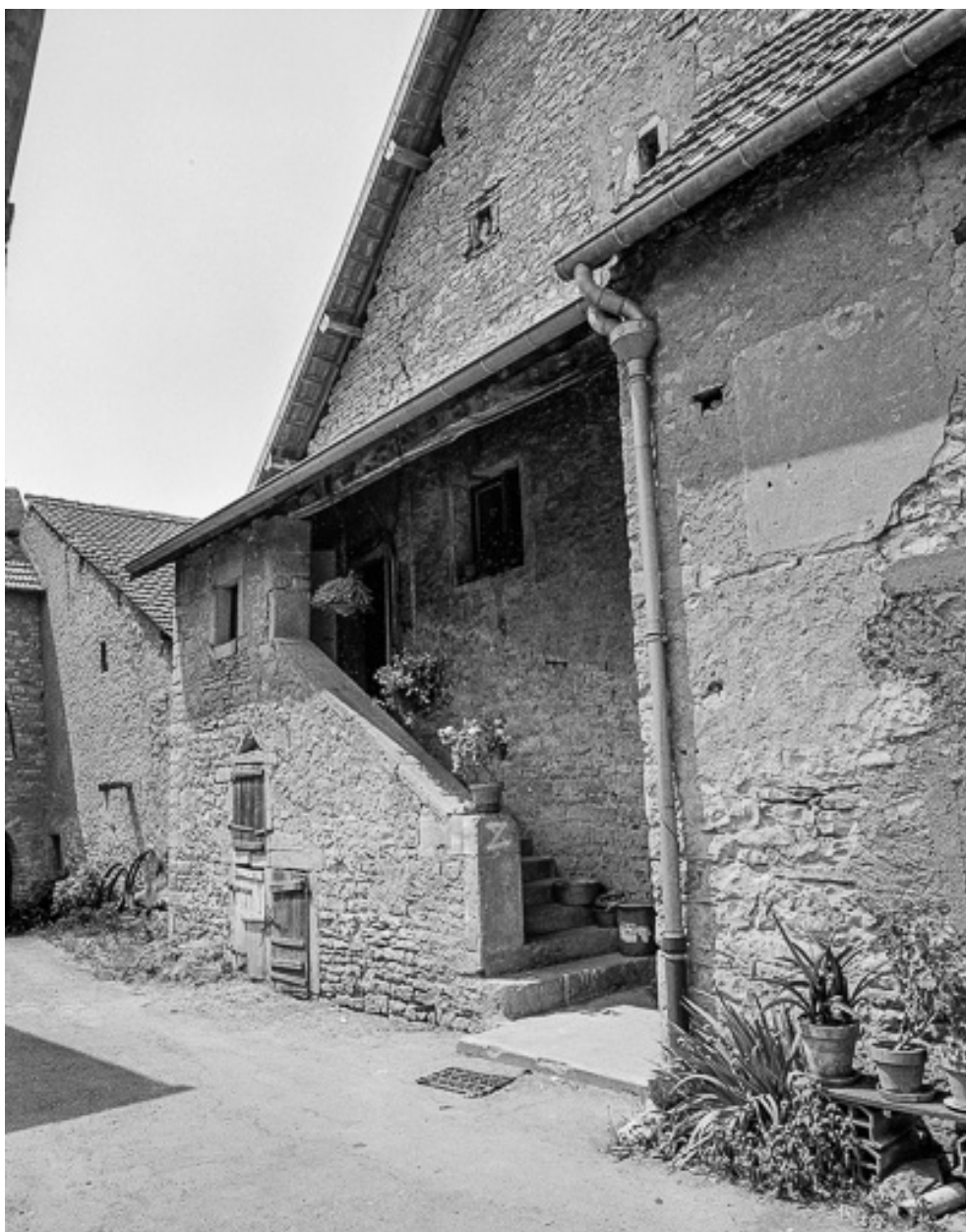
Ferme cadastrée 1973 AB 92, située entre la rue de la Traverse et la rue de l'Arcade : escalier, façade antérieure.
