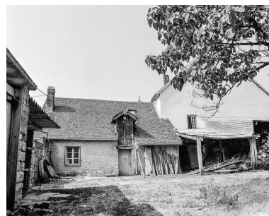
Maison cadastrée 1973 AB 11 située rue d'Aval à Chenevrey : détail de la façade latérale droite. Phot. Dominique Humbert IVR43_19767000485X
