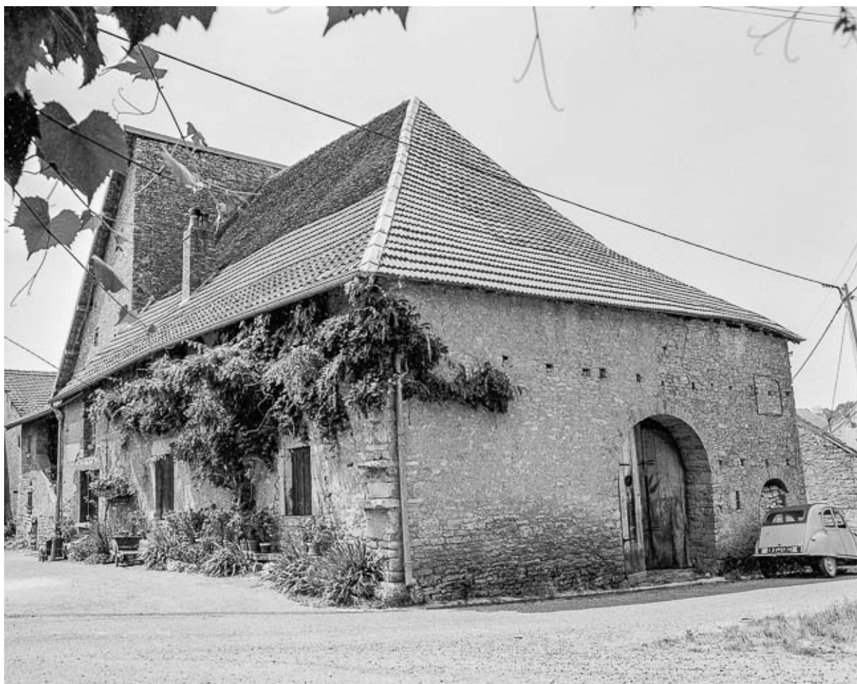
Ferme cadastrée 1973 AB 92, située entre la rue de la Traverse et la rue de l'Arcade : façade antérieure et face latérale droite.
