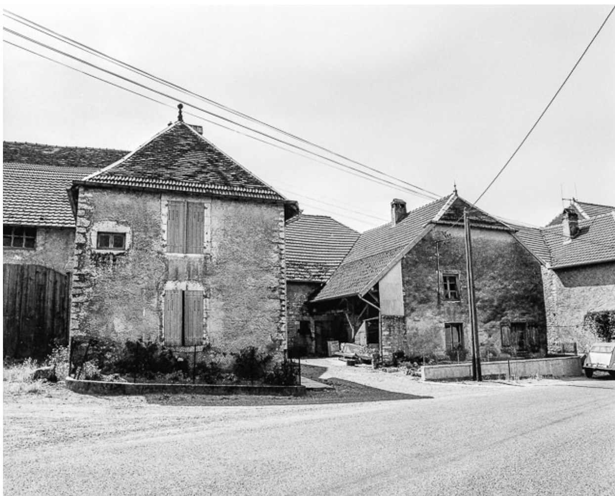
Maisons situées rue de Montbozon.: façades donnant sur la rue.
