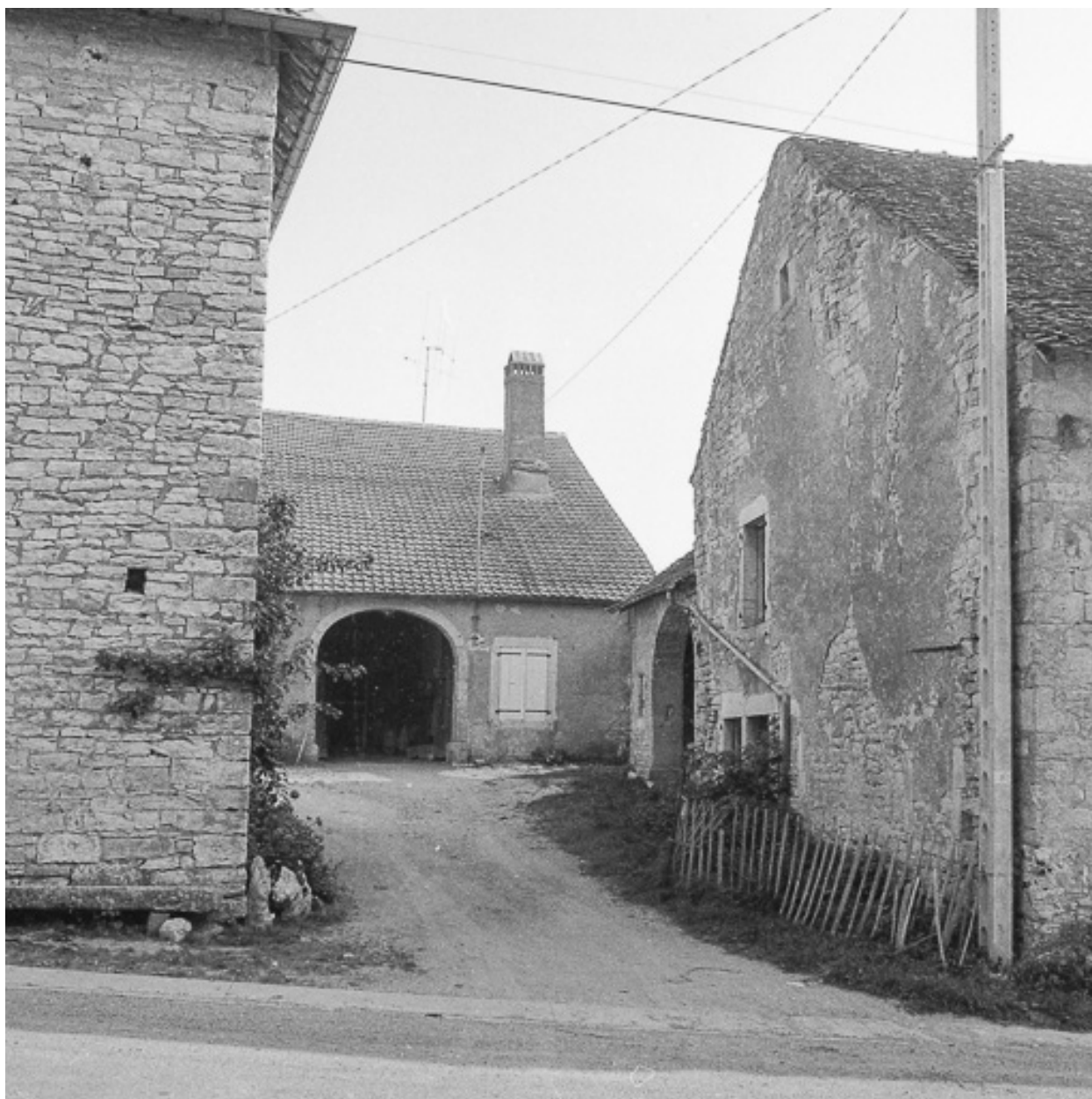
Ferme cadastrée 1973 AB 169.: bâtiment en fond de cour.
