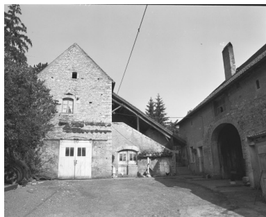
Ferme située rue d'Aval à Chenevrey : vue d'ensemble. Phot. Dominique Humbert IVR43_19767000476X
