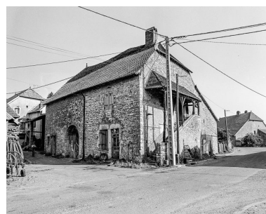
Ferme située rue d'Aval à Chenevrey : vue d'ensemble. Phot. Bernard Lardière IVR43_19767000441X
