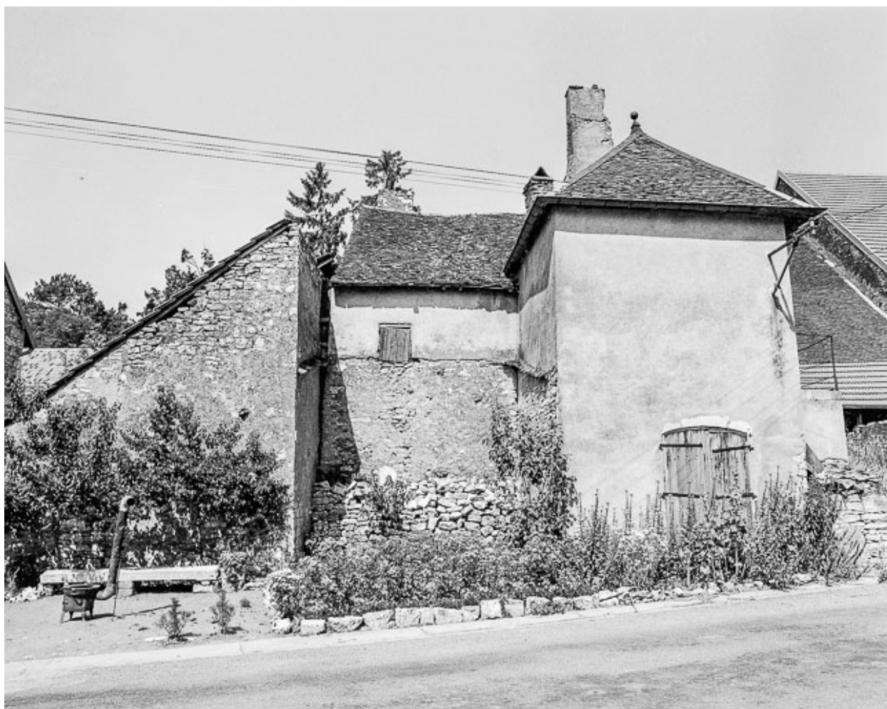
Maison située rue de Marnay : façades postérieure et latérale gauche.
