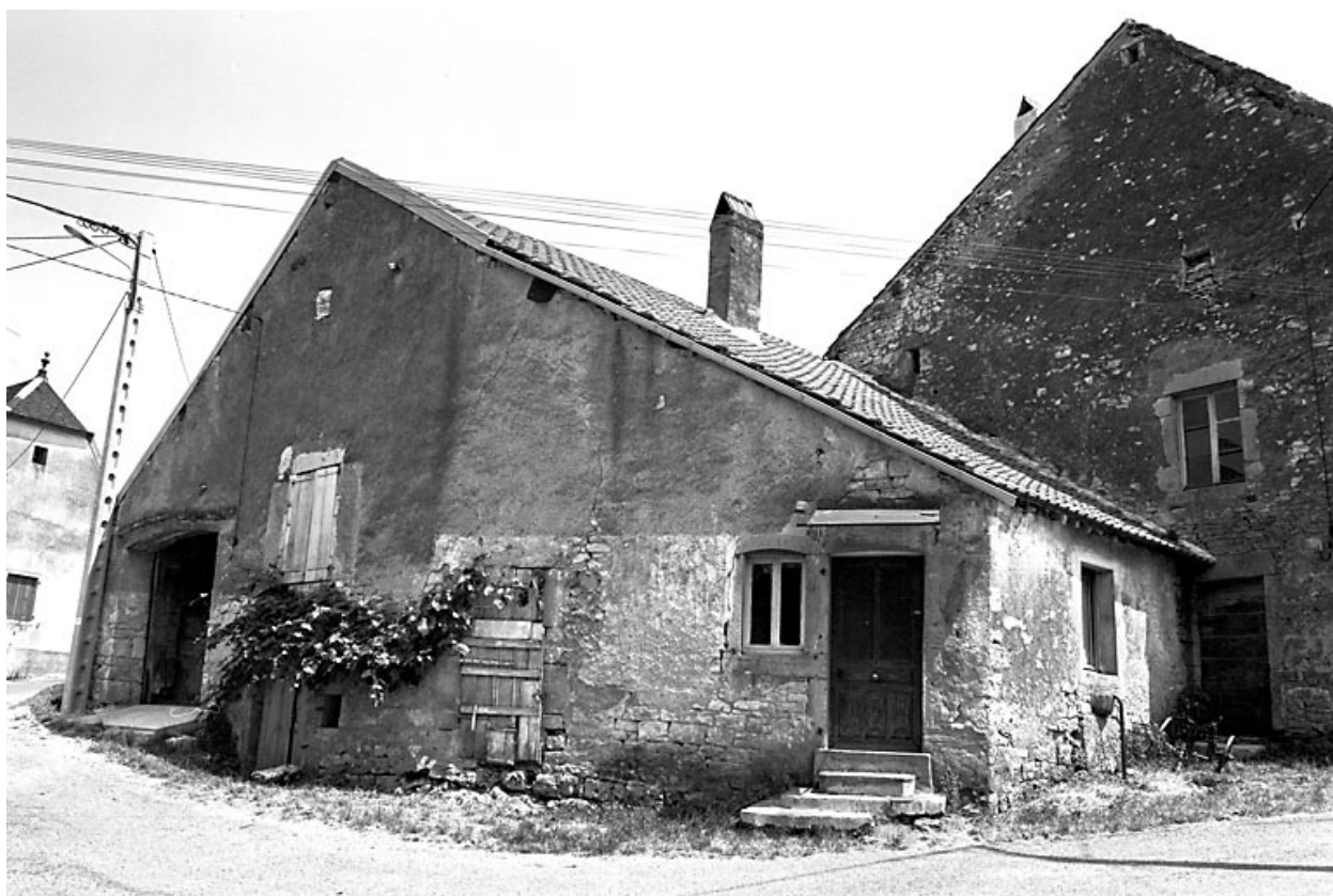
Ferme située rue de l'Arcade à Chenevrey : vue d'ensemble.
