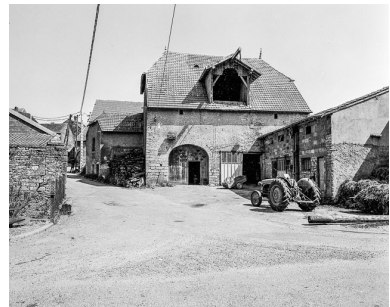
Fermes situées rue de la Traverse à Chenevrey. Phot. Dominique Humbert IVR43_19767000468X
