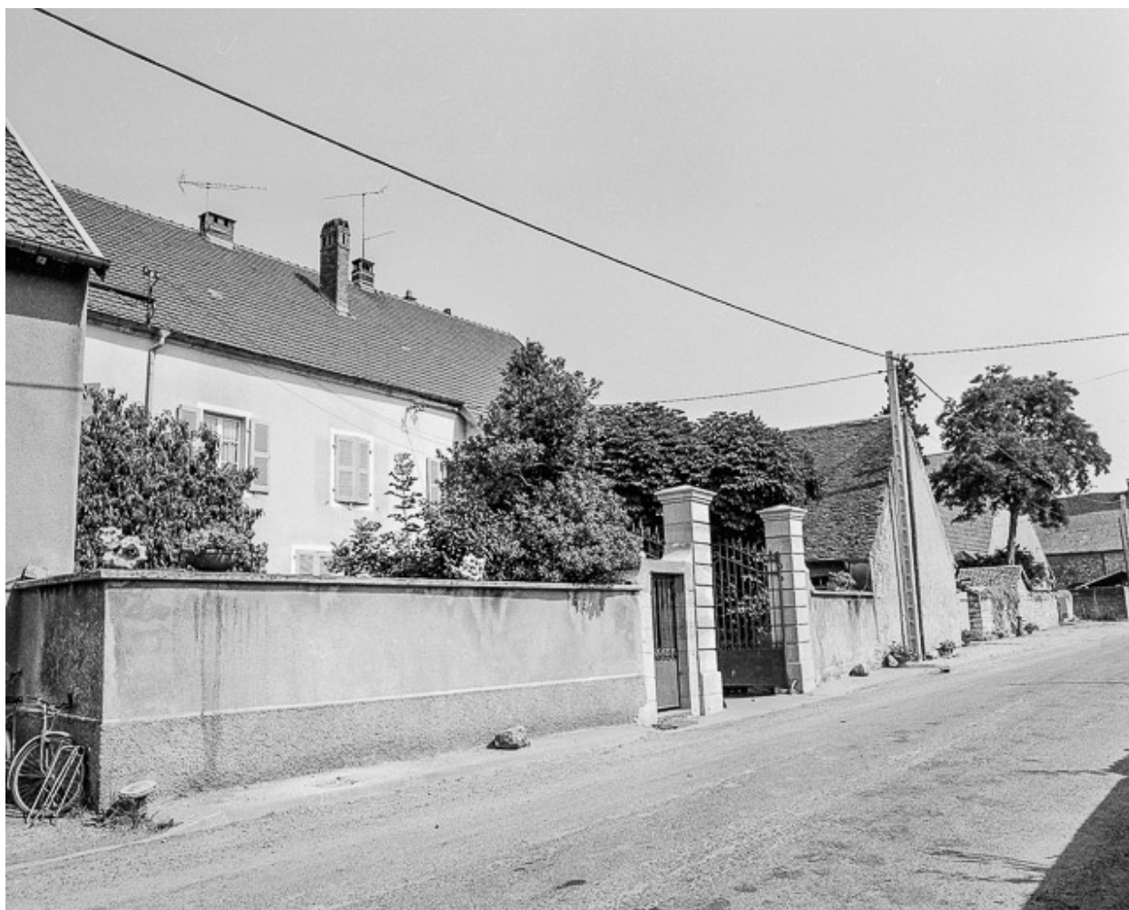
Maison cadastrée 1973 AB 11 située rue d'Aval à Chenevrey : façade antérieure et cour.
