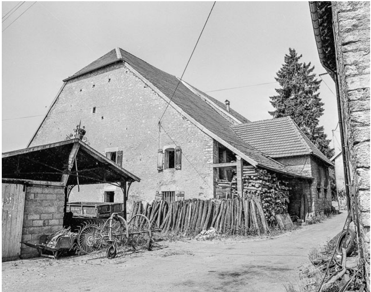
Maison située rue d'Aval à Chenevrey : façades antérieure et latérale droite.
