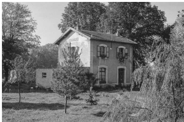
Gare de voyageurs, actuellement maison : vue d'ensemble. Phot. Bernard Lardière IVR43_19797000363Z
