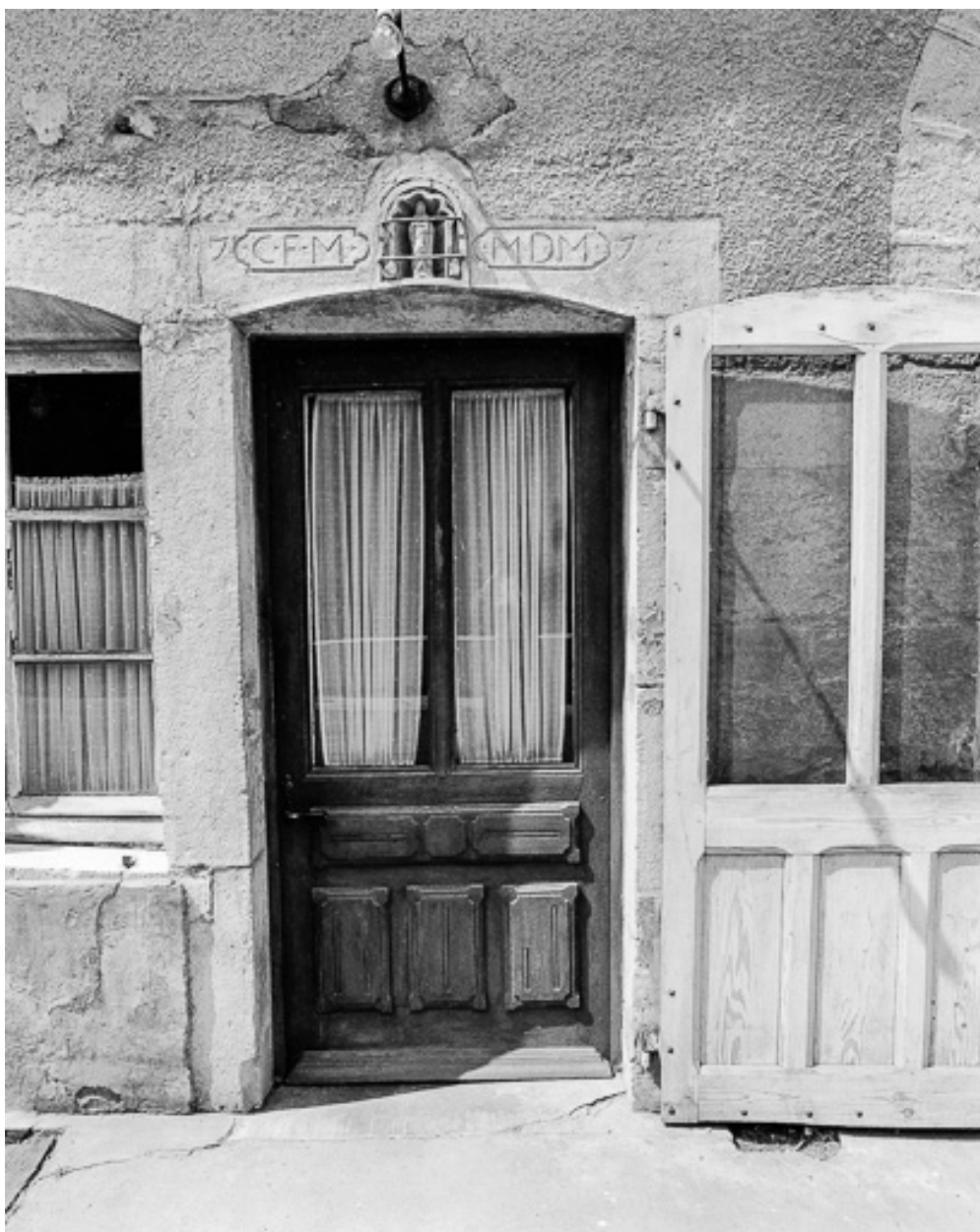
Ferme située entre la rue d'Amont et la rue de la Fontaine : porte d'entrée, façade antérieure.
