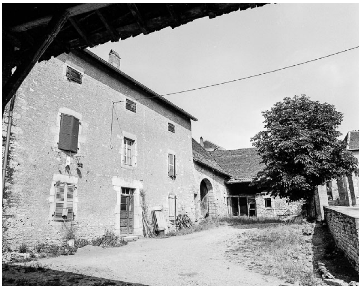
Ferme cadastrée 1973 AB 27 située rue d'Amont à Chenevrey : façade antérieure et dépendances.
