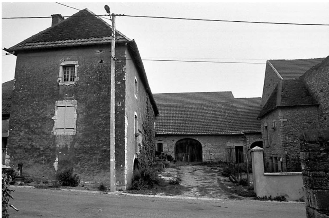
Ferme située rue d'Amont à Chenevrey : vue d'ensemble.
