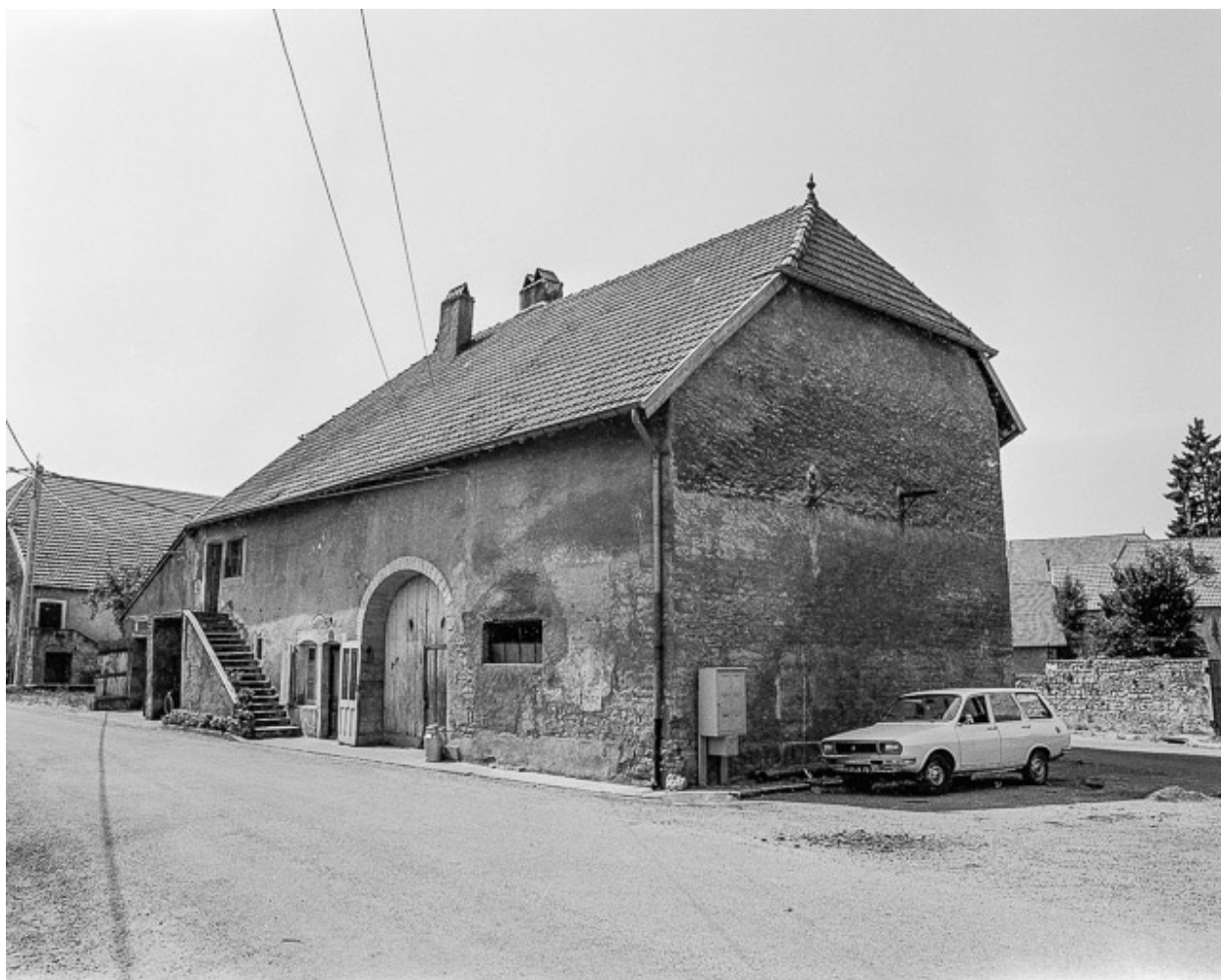
Ferme située entre la rue d'Amont et la rue de la Fontaine : façade antérieure et façade latérale droite.
