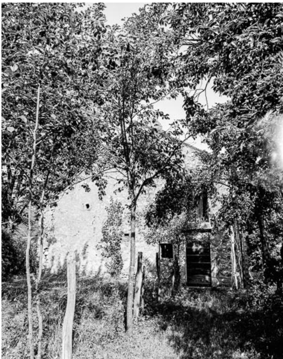
Maison cadastrée 1973 AB 104, située rue des Escaliers.: façade antérieure.
