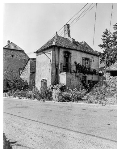
Ferme située rue de la Traverse à Chenevrey : vue d'ensemble. Phot. Bernard Lardière IVR43_19767000473X
