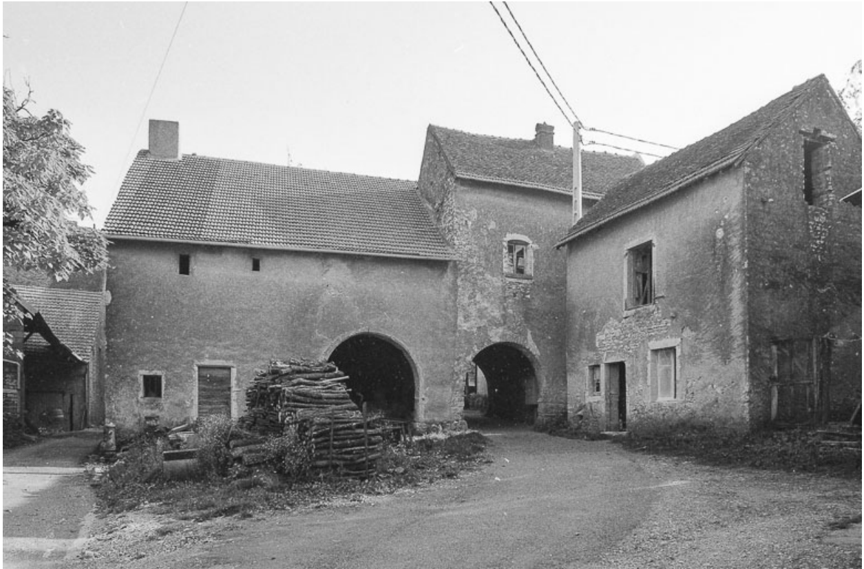
Maison de vigneron située rue de l'Arcade à Chenevrey : vue d'ensemble.
