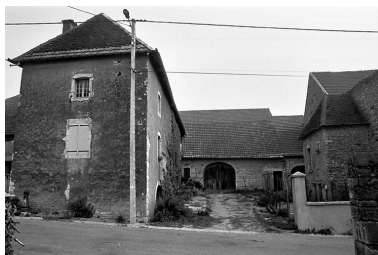
Ferme située rue d'Amont à Chenevrey : vue d'ensemble. Phot. Bernard Lardière IVR43_19797000352Z
