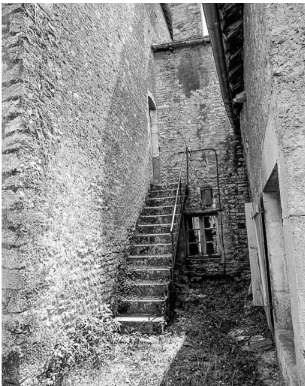
Maison située entre la rue de la Traverse et la ruelle des Escaliers : façade postérieure avec escaliers.
