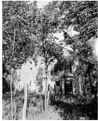
Maison cadastrée 1973 AB 104, située rue des Escaliers.: façade antérieure. Phot. Dominique Humbert IVR43_19767000514X
