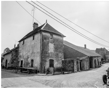
Maison située à l'angle de la rue d'Aval et rue de la Traverse. Phot. Dominique Humbert IVR43_19767000498X
