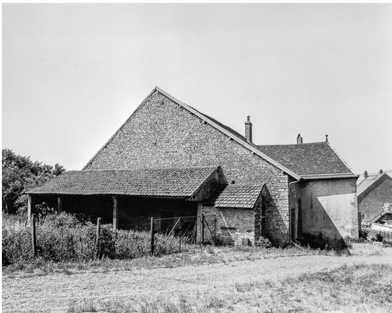
Maisons situées rue de Montbozon.: façades latérales gauches.
