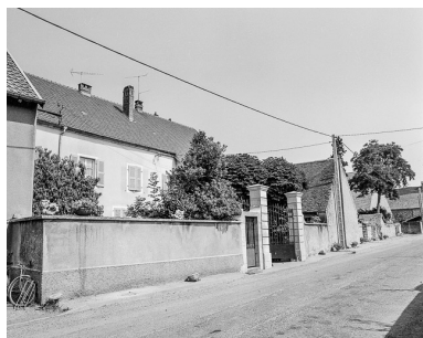
Maison cadastrée 1973 AB 11 située rue d'Aval à Chenevrey : façade antérieure et cour. Phot. Dominique Humbert IVR43_19767000483X
