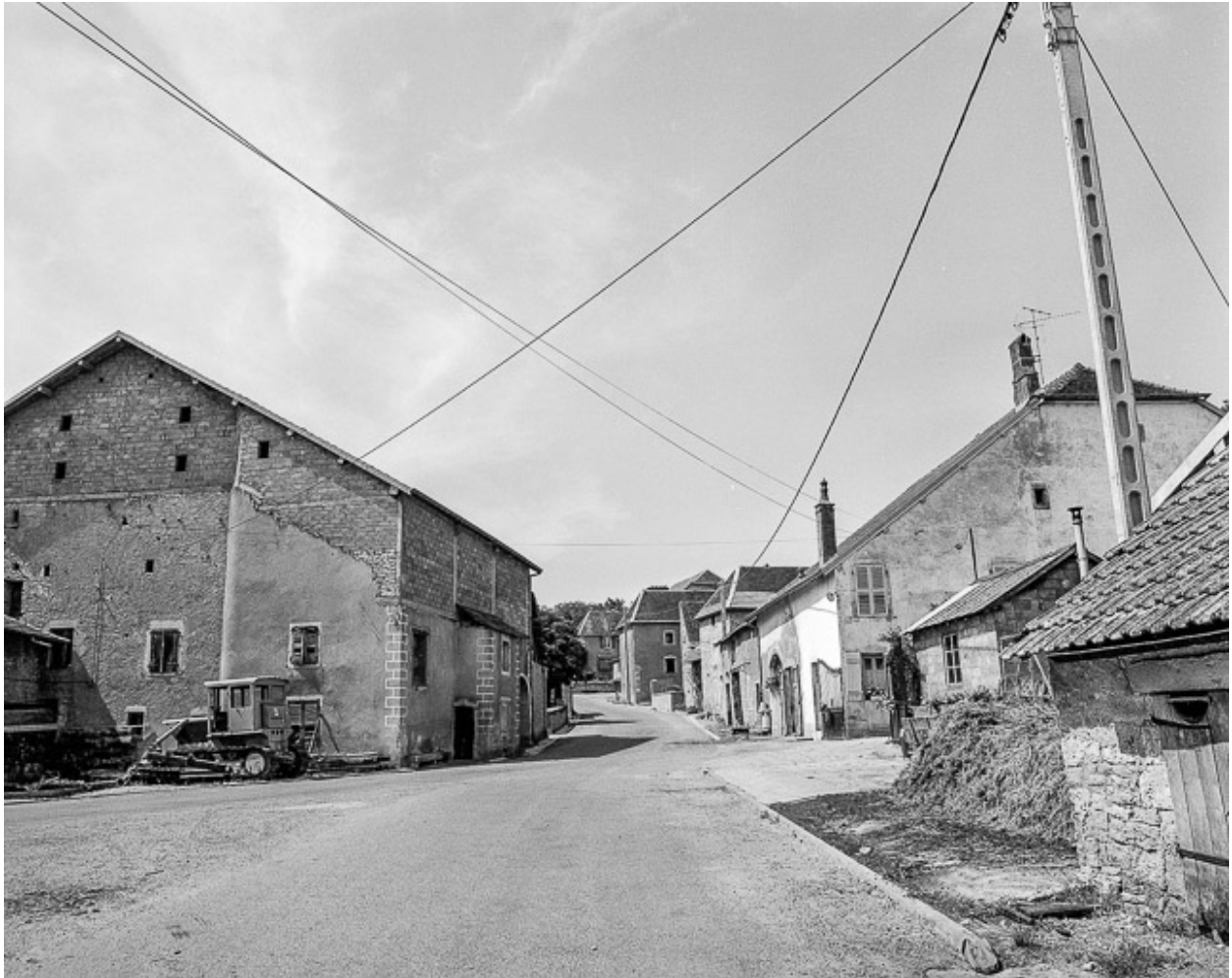
Maison située rue d'Amont à Chenevrey : façade latérale gauche.
