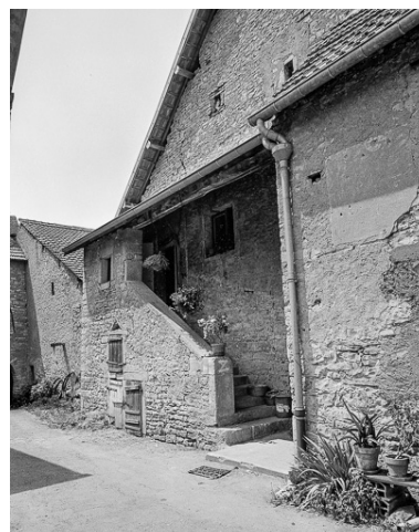
Ferme cadastrée 1973 AB 92, située entre la rue de la Traverse et la rue de l'Arcade : escalier, façade antérieure. Phot. Dominique Humbert IVR43_19767000502X
