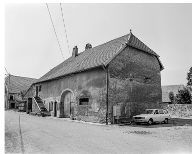
Ferme située entre la rue d'Amont et la rue de la Fontaine : façade antérieure et façade latérale droite. Phot. Dominique Humbert IVR43_19767000510X
