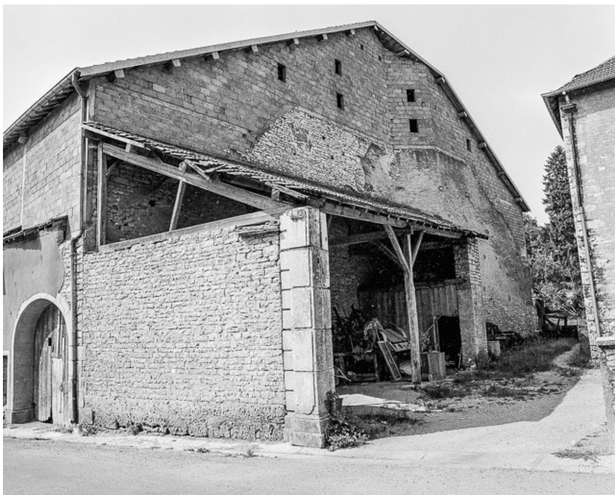
Ferme cadastrée 1973 AB 27 située rue d'Amont à Chenevrey : hangar situé à gauche de la maison.
