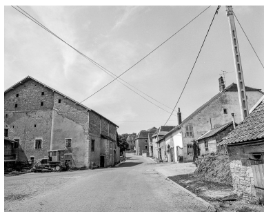
Maison située rue d'Amont à Chenevrey : façade latérale gauche. Phot. Dominique Humbert IVR43_19767000453X
