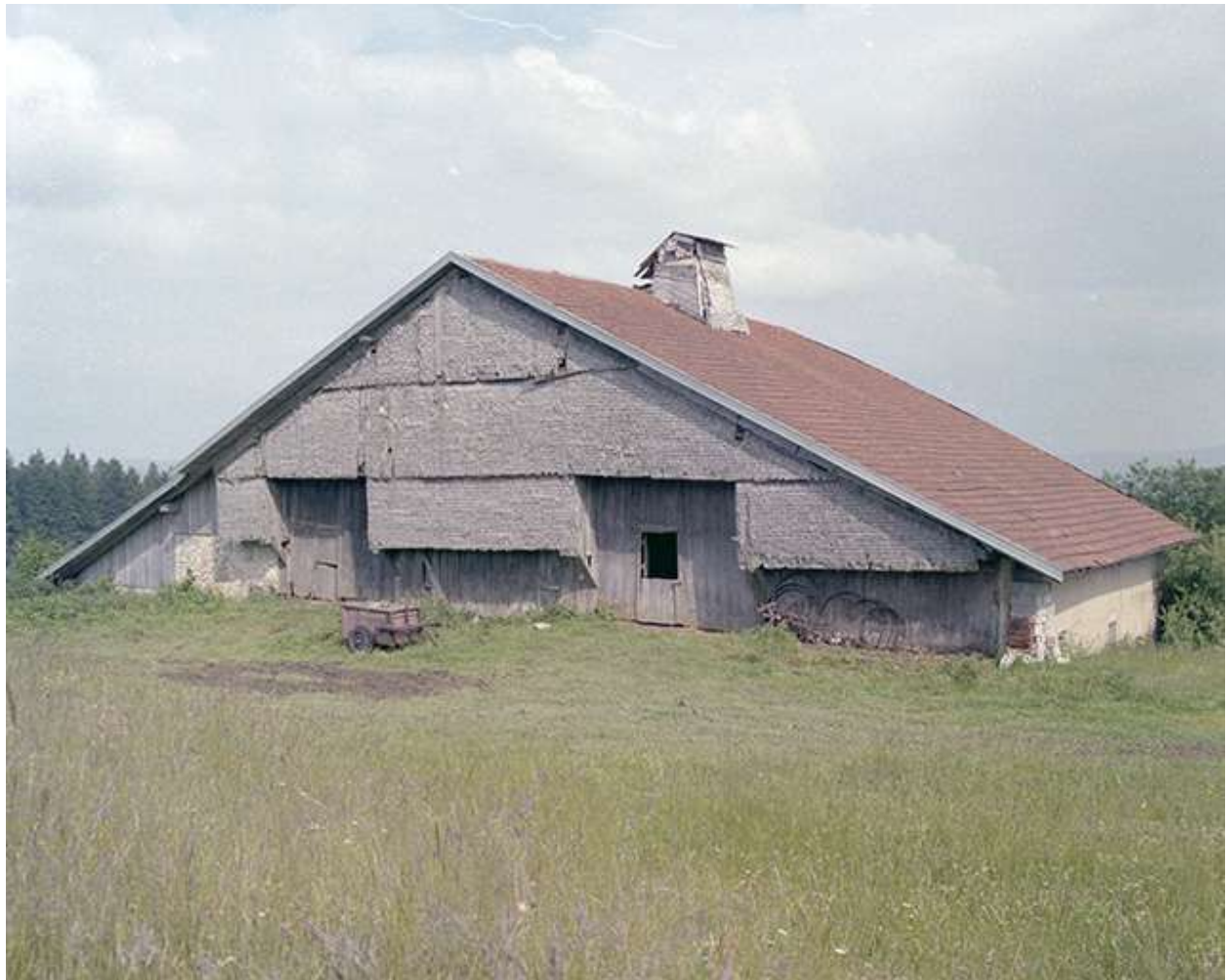
Façades postérieure et latérale gauche.
