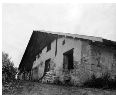
Détail du pignon antérieur. Phot. Yves Sancey IVR43_19782500190X
