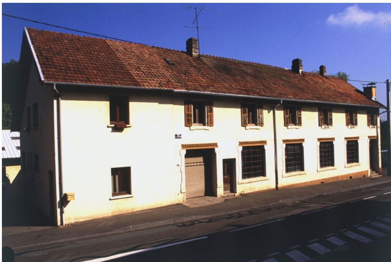
Façade sur rue de l'atelier de fabrication.
