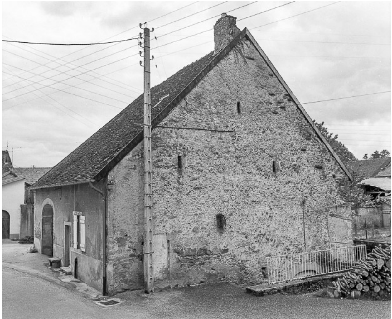
Façades antérieure et latérale droite.
