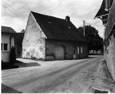
Façades antérieure et latérale gauche.
