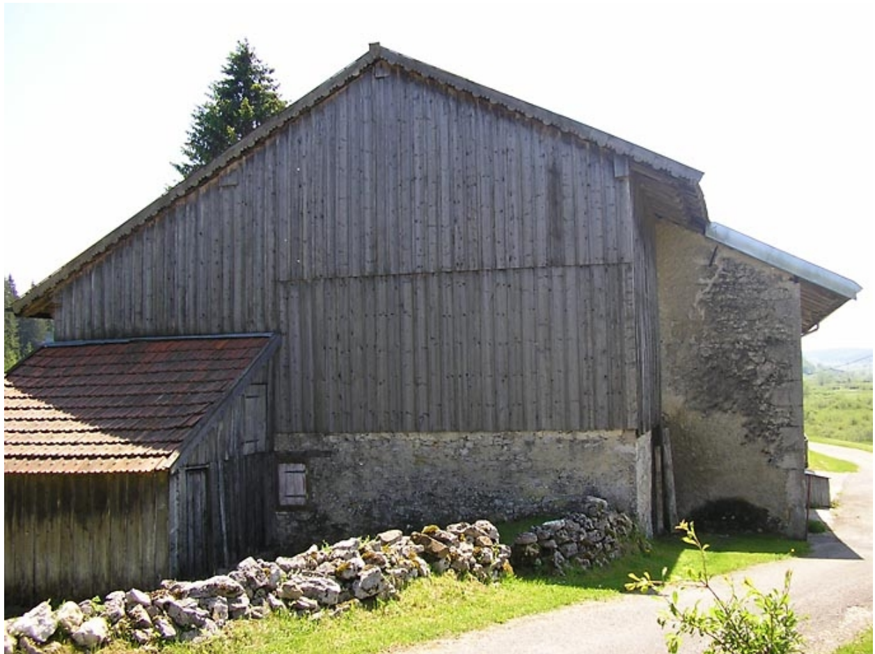
Le pignon nord-est et l'appentis.
