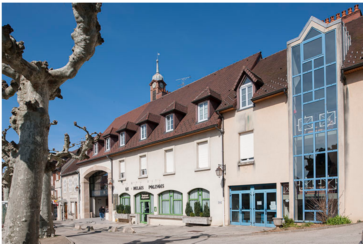
Restaurant d'application: façade antérieure, place des déportés.
