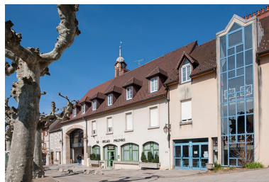
Restaurant d'application: façade antérieure, place des déportés.
