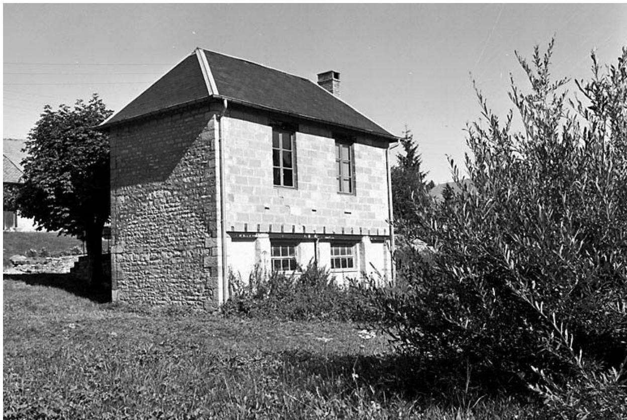
Façade postérieure et face latérale droite.
