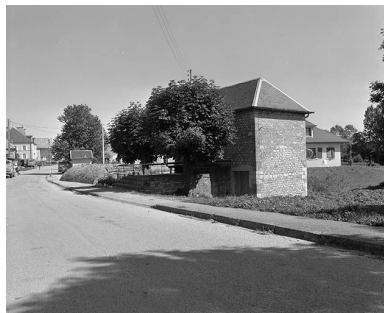
Vue générale. Phot. Yves Sancey IVR43_19802500944X
