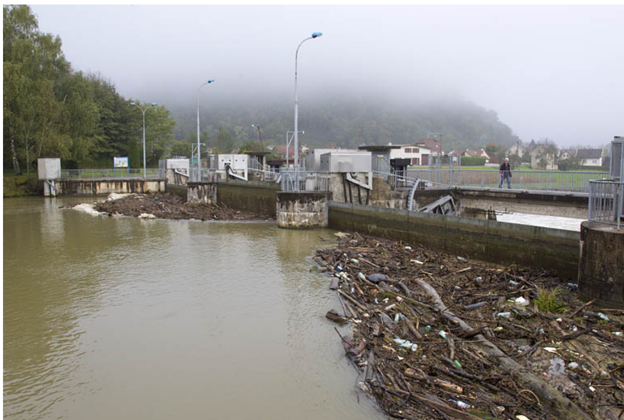
Retenue d'eau en amont du barrage.
