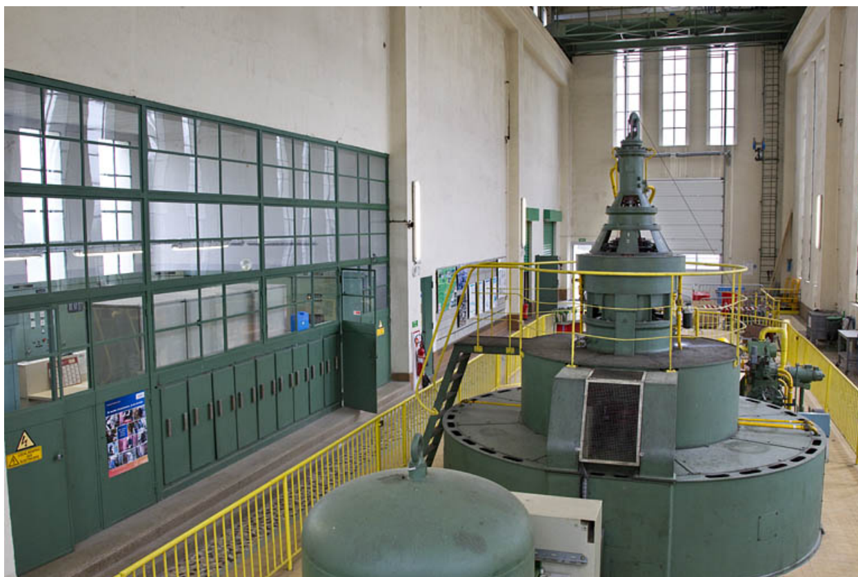
Salle des commandes et groupe turbo-alternateur n°2.
