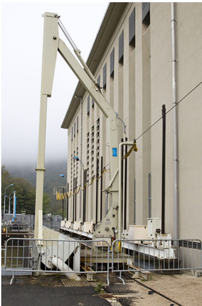
Dégrilleur et façade sud de la centrale.
