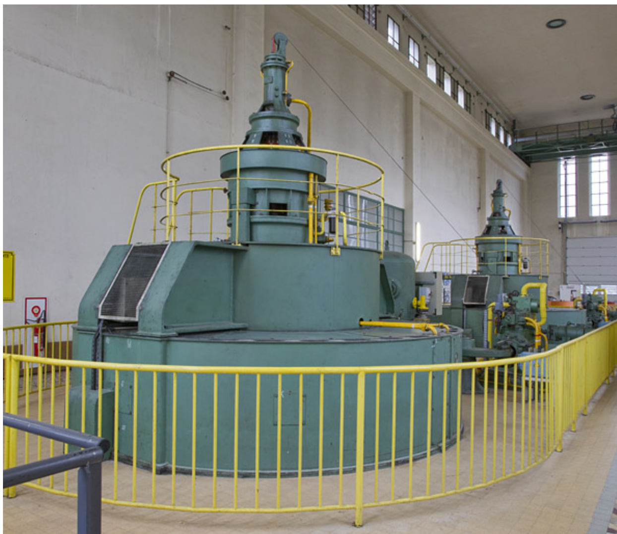
Groupes turbo-alternateurs. Vue rapprochée.
