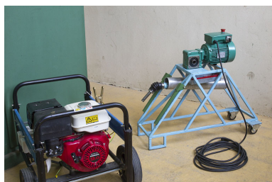
Groupe électrogène et appareil électrique de secours (commande du vannage). Phot. Yves Sancey IVR43_20122501951NUC2A
