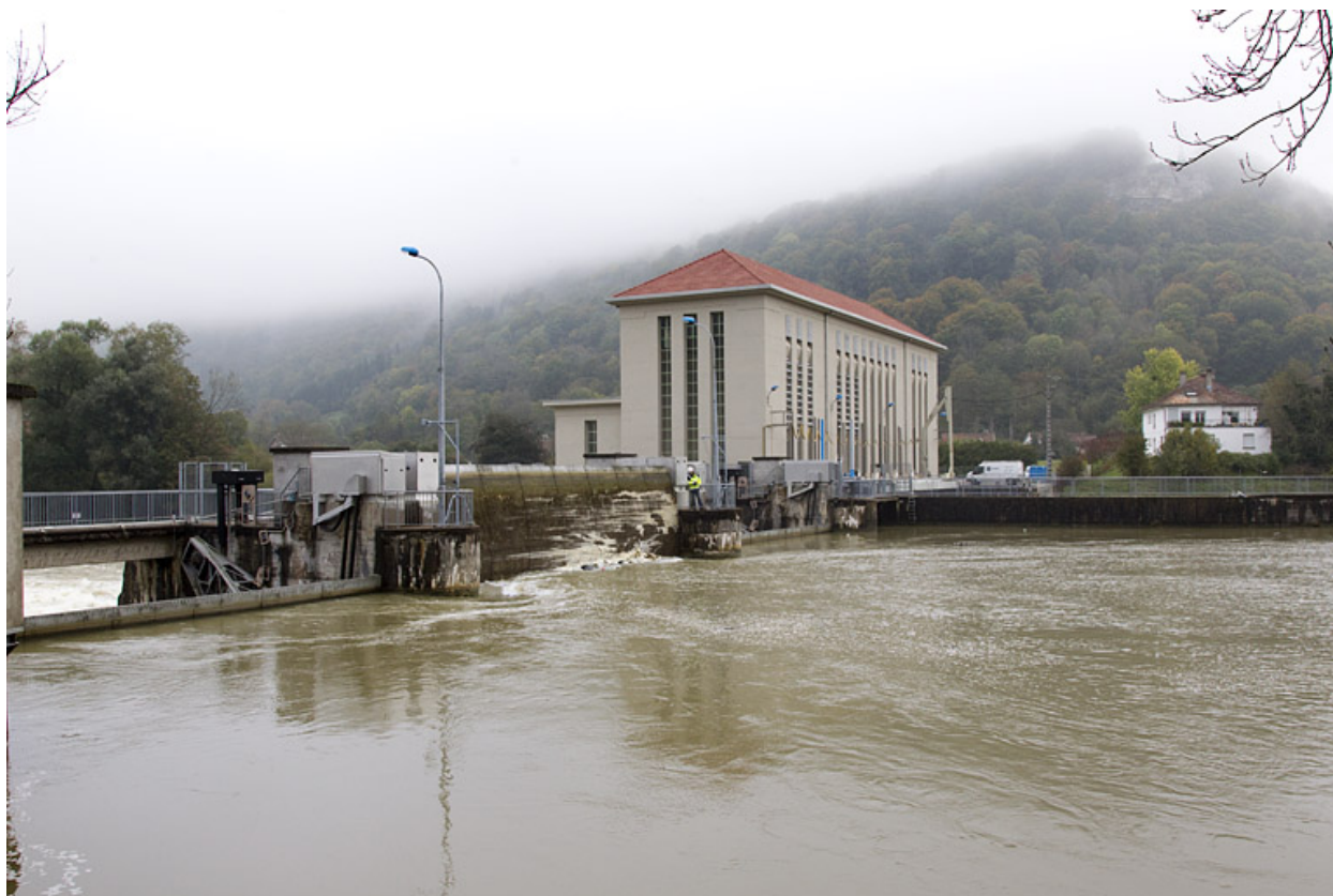
Le barrage et la centrale depuis l'ouest.
