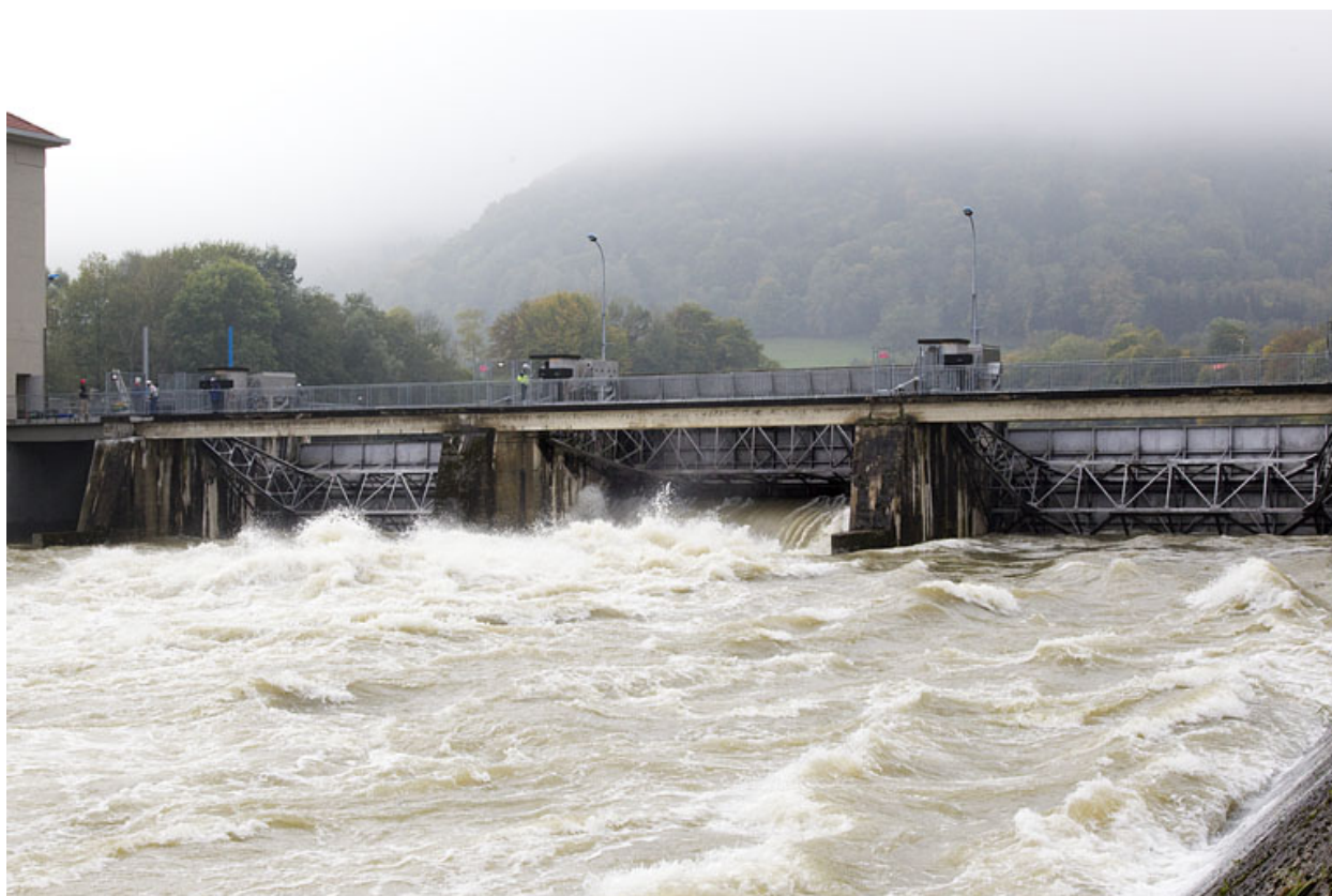
Délestage des vannes segments.
