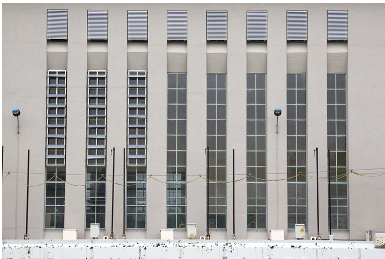
Détail des baies de la façade sud.
