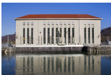
Façade sud de la salle des machines. Phot. Yves Sancey IVR43_20122501938NUC2A
