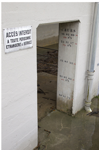
Partie inférieure de la salle des commandes. Marquage du niveau des crues. Phot. Yves Sancey IVR43_20122501957NUC2A
