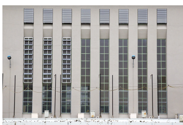
Détail des baies de la façade sud.
