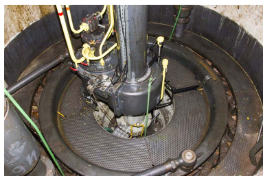
Partie supérieure d'une turbine et axe de transmission vertical. Phot. Yves Sancey IVR43_20122501952NUC2A
