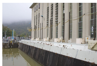
Grille d'admission de la centrale.
