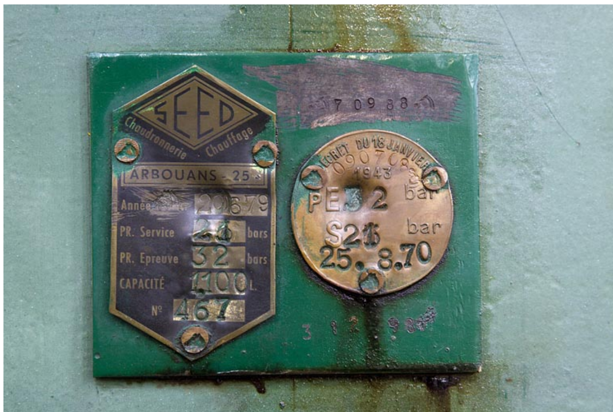
Réservoir d'air comprimé. Plaque d'épreuve.
