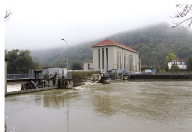
Le barrage et la centrale depuis l'ouest. Phot. Yves Sancey IVR43_20122501967NUC2A
