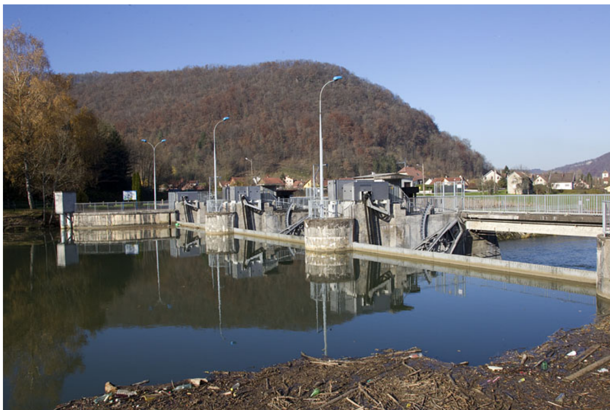
Le vannage en amont du barrage.
