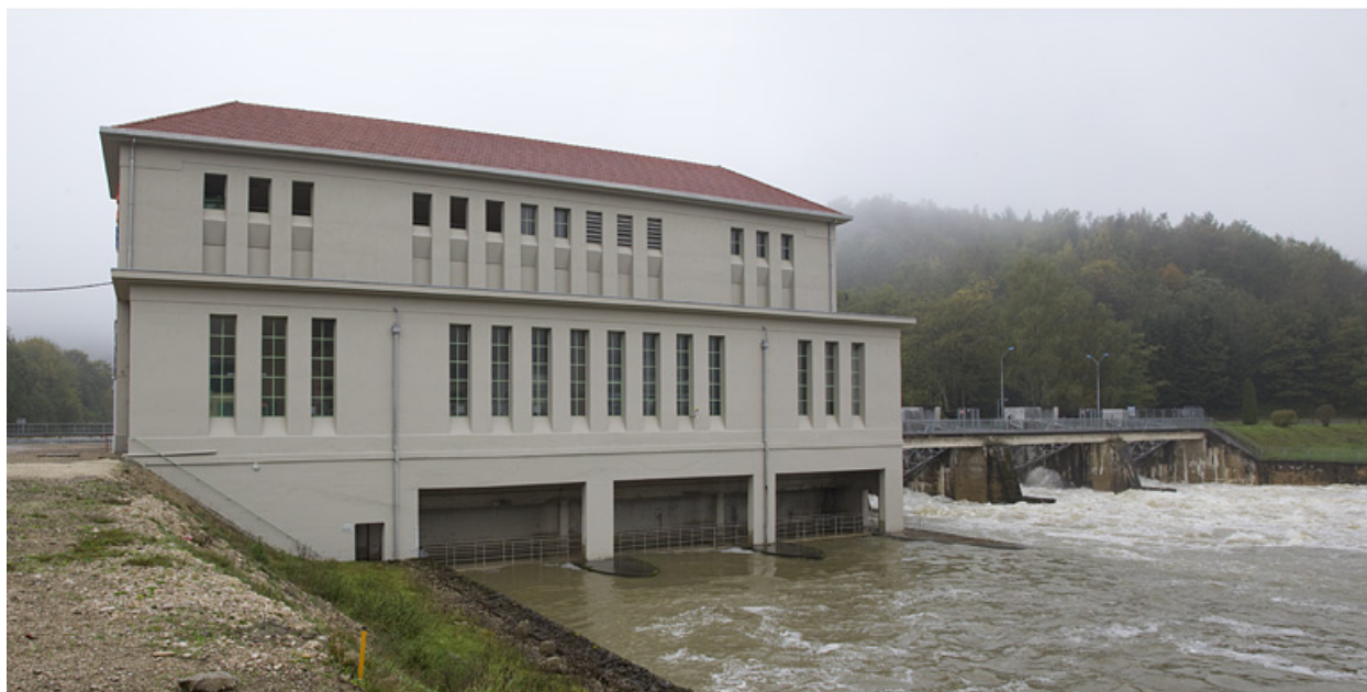
Façade aval depuis le nord.
