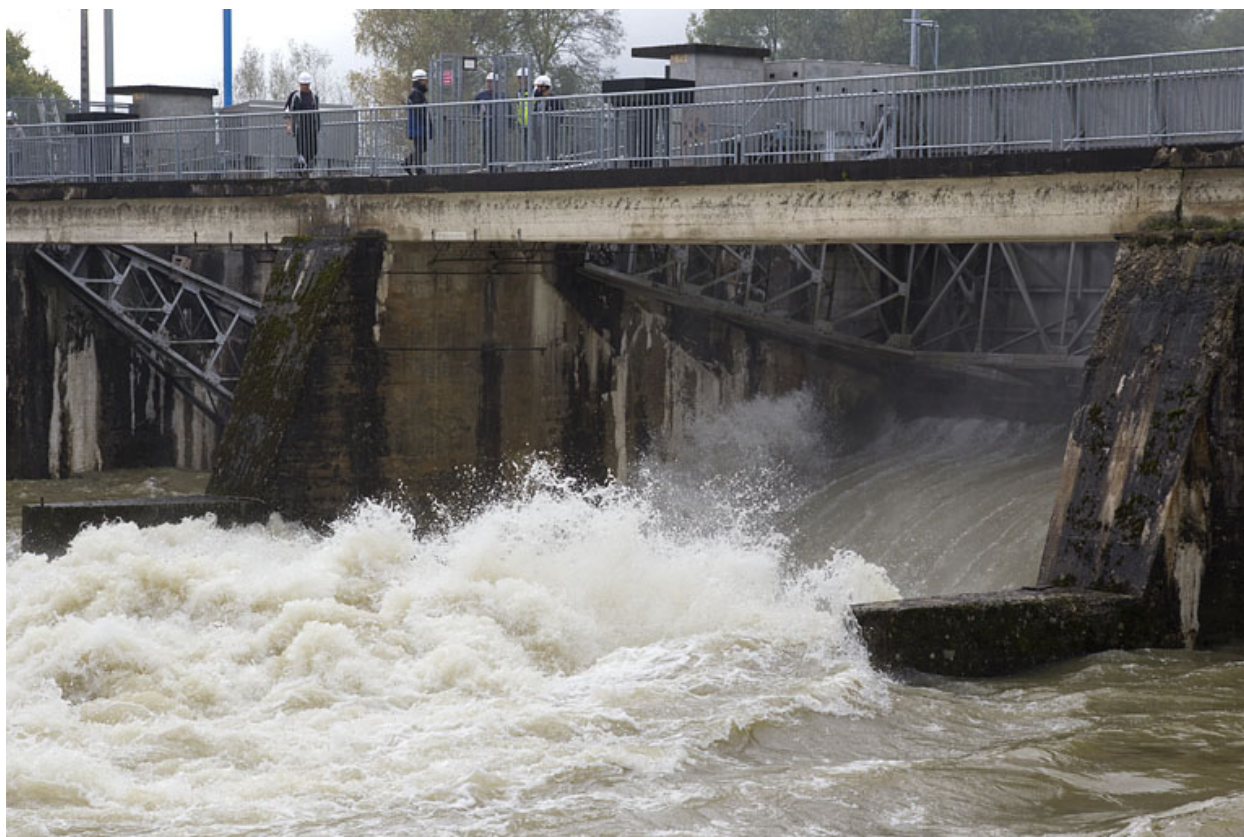
Délestage de la vanne segment centrale.
