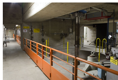
Etage inférieure de la salle des machines. Phot. Yves Sancey IVR43_20122501953NUC2A
