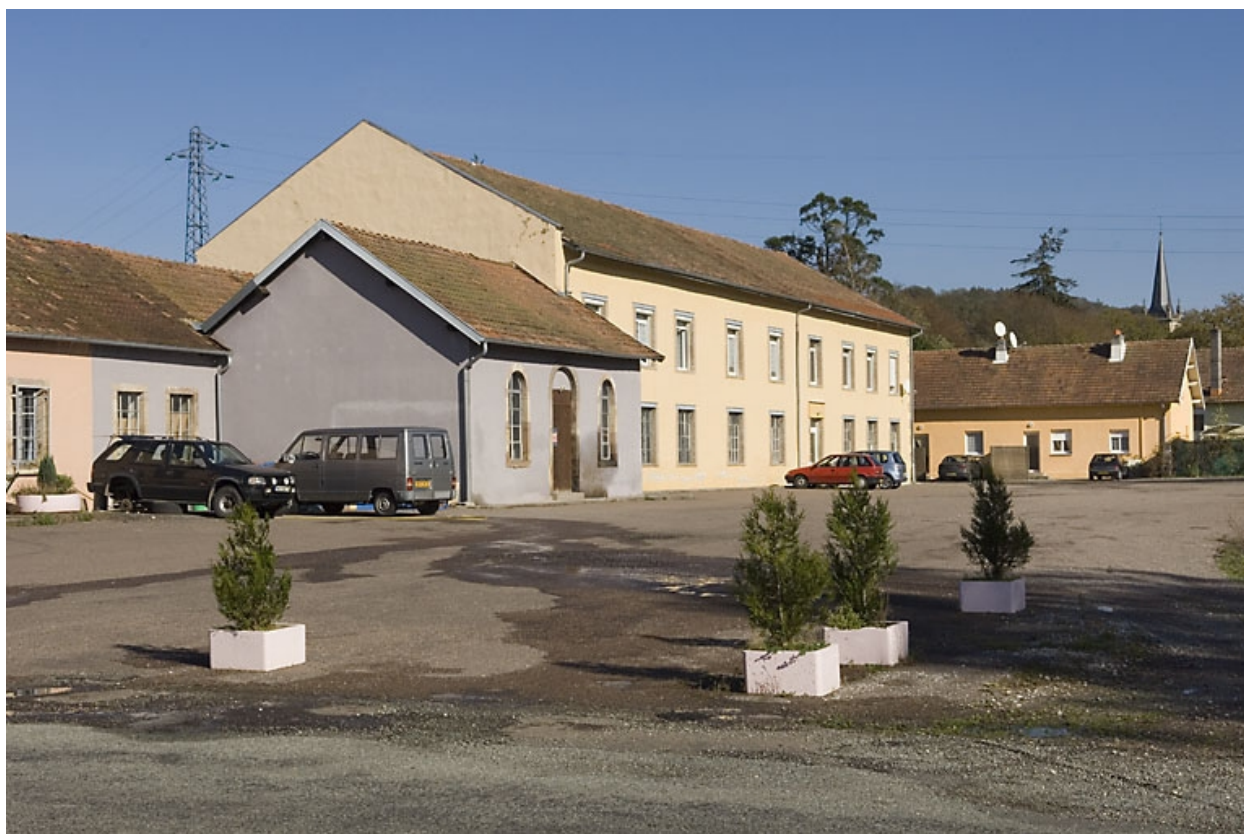
Façades sud. Chaufferie et atelier de fabrication (?).
