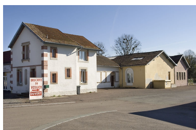
Logement et bureaux depuis l'ouest. Phot. Jérôme Mongreville IVR43_20067000977NUCA
