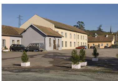
Façades sud. Chaufferie et atelier de fabrication (?). Phot. Jérôme Mongreville IVR43_20067000976NUCA
