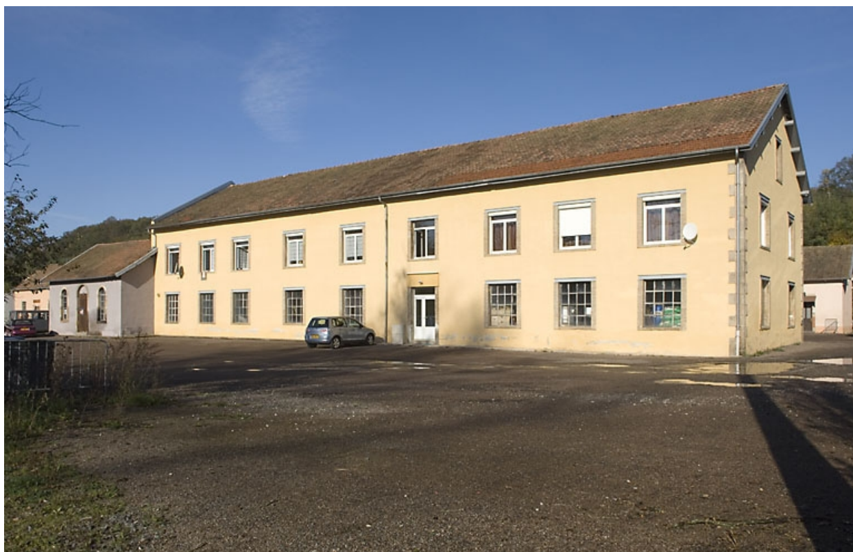
Atelier de fabrication sud (?).
