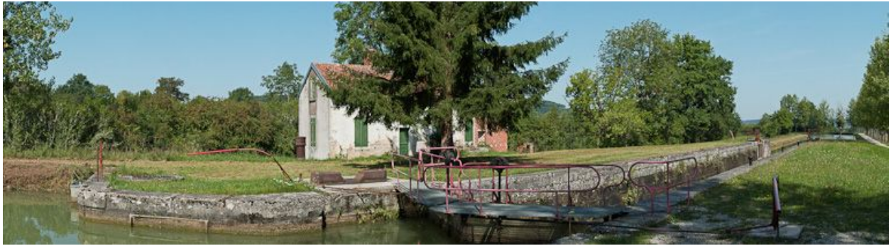
Vue d'ensemble du site d'écluse.
