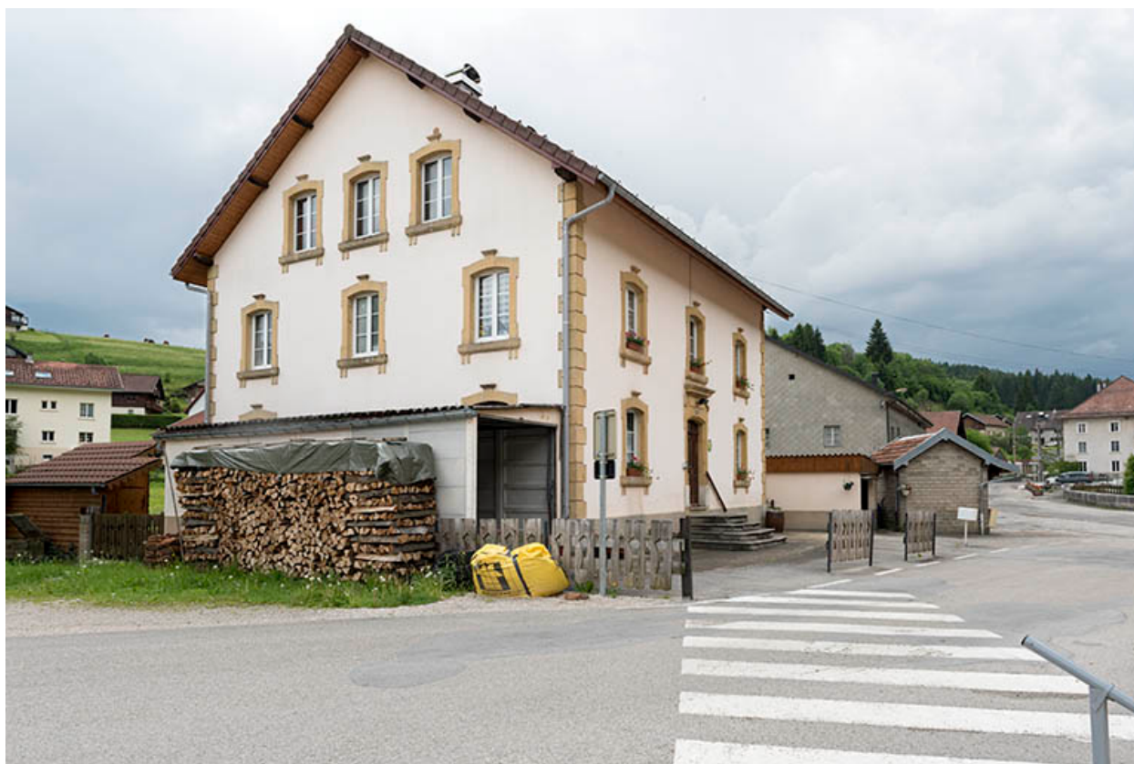
Façades antérieure et latérale gauche.
